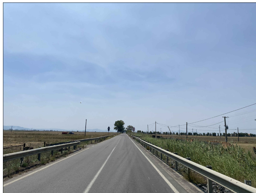
STRADA DI NORMALE ACCESSIBILITA' 2: SP69ii (VERSO OVEST) - ANTE OPERAM
