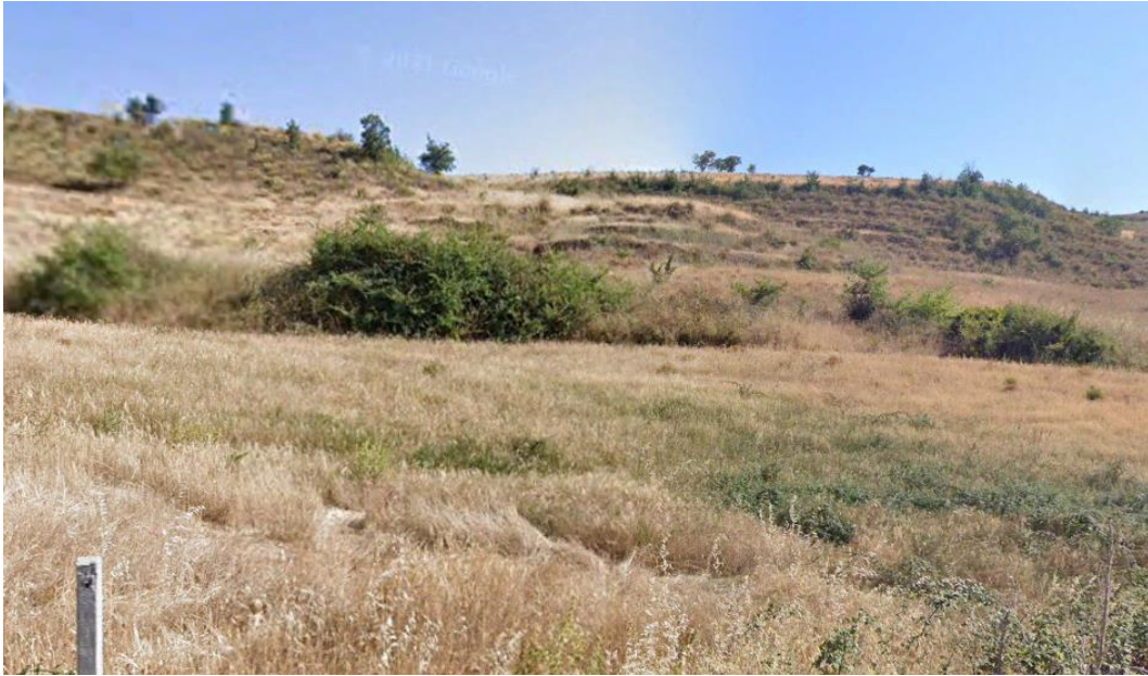
Foto 25. Superfici Aerogeneratore PV12
