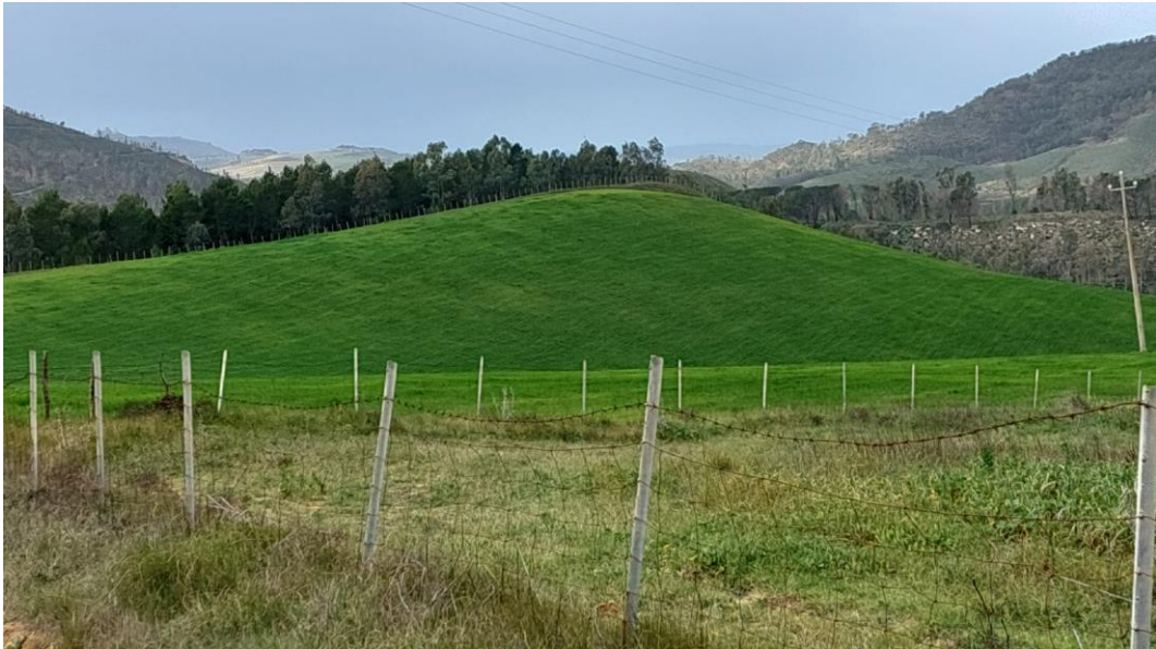
Foto 21, 22. Superfici Aerogeneratore PV10
