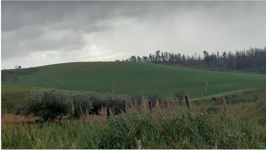
Foto 15, 16. Superfici Aerogeneratore PV07
