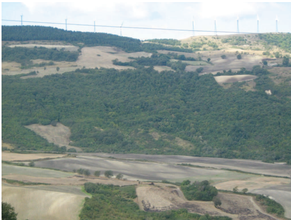
Foto 4 – Il passaggio dell'elettrodotto interessa solo limitatamente aree forestali come nel caso dei versanti sottesi dal torrente Vulgano. Ma in questo caso i sostegni saranno posizionati al margine delle aree boscate o nelle radure
