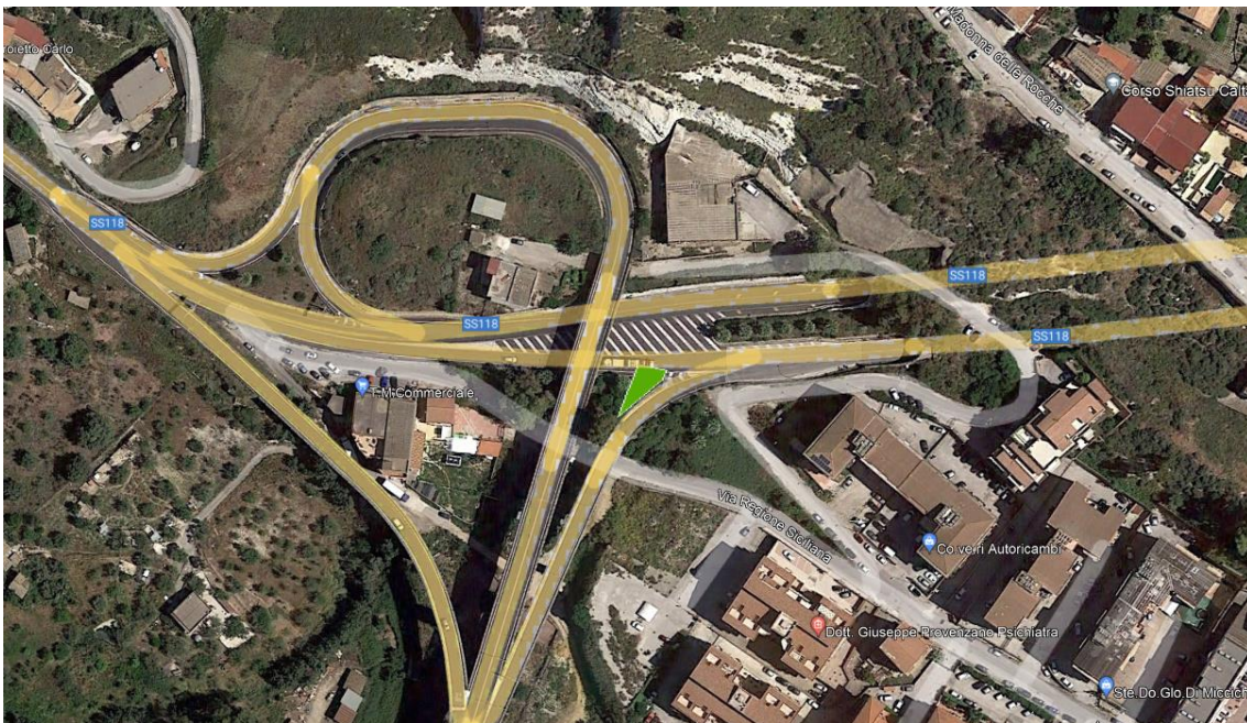
Allargamento della rampa di collegamento tra la SS 626 e a SS190
