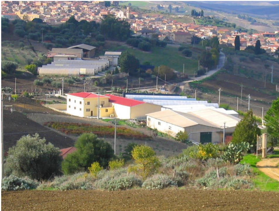
Figura 108 - Vista panoramica Comune di Villalba
