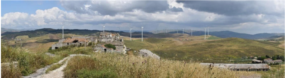
Figura 156 - Stato di fatto del punto di scatto F62
