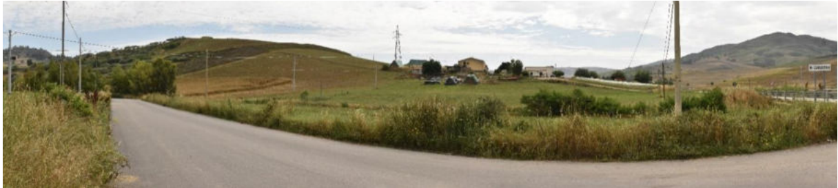
Figura 99 - Stato di fatto del punto di scatto F44
