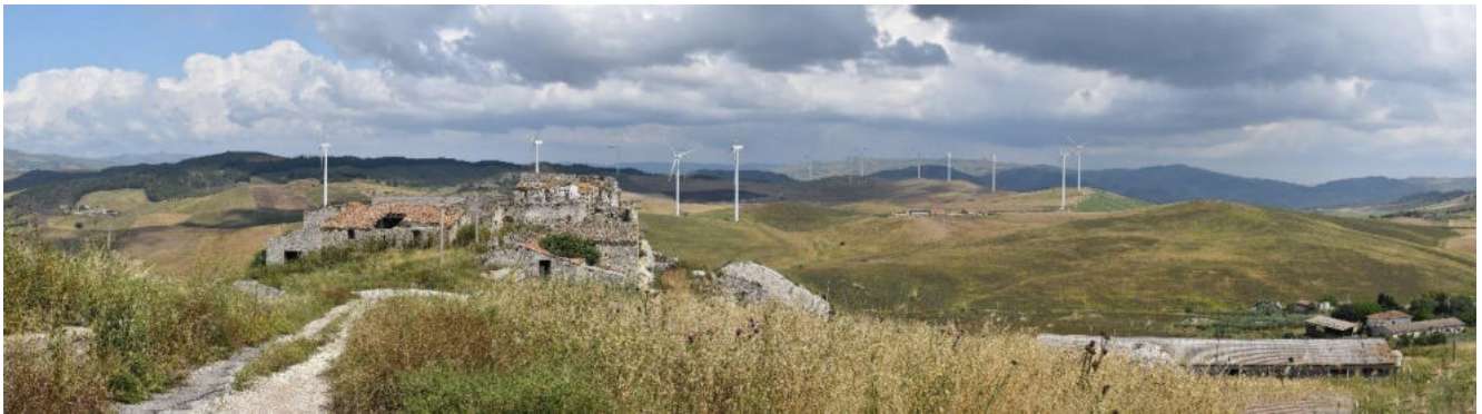
Figura 104 - Stato di fatto del punto di scatto F62
