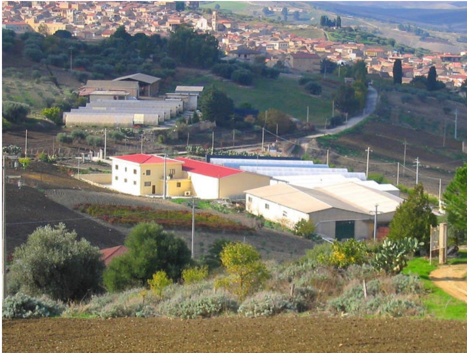
Figura 64 - Vista panoramica Comune di Villalba
