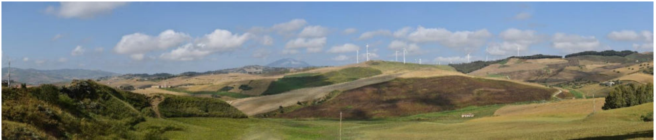
Figura 134 - Stato di fatto del punto di scatto F47
