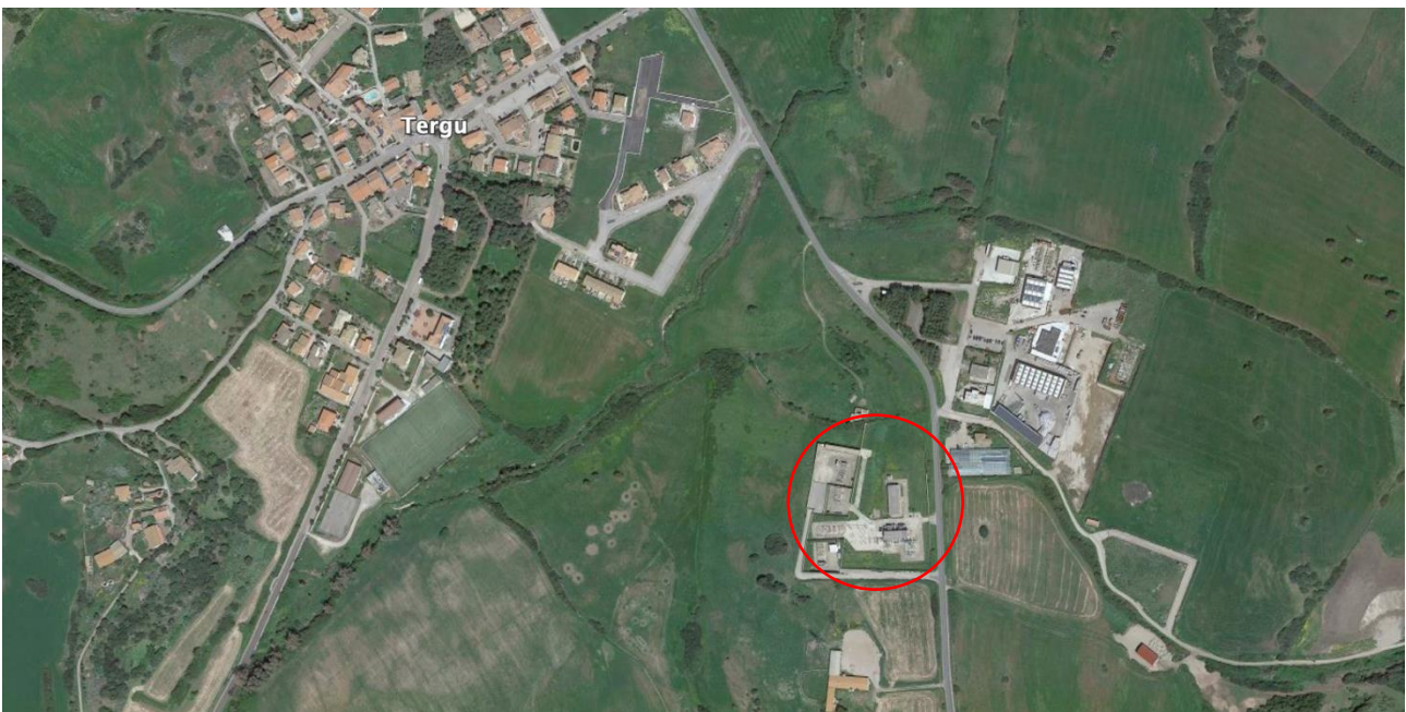
Fig. 18: Stazione elettrica di Tergu.
