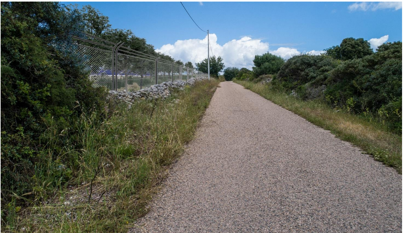
Fig. 121-122: Stato di fatto e opere di mitigazione.
