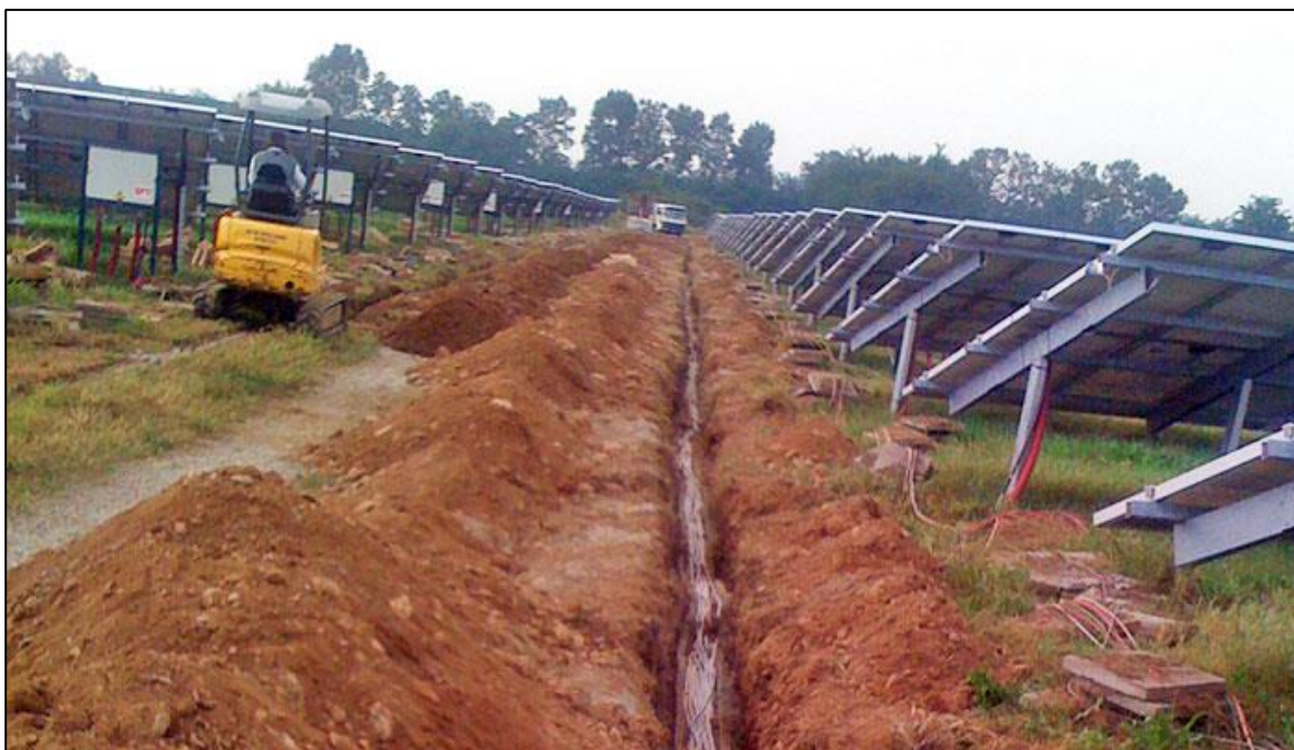
Figura 16 – Tipico di scavo per cavi BT/MT
