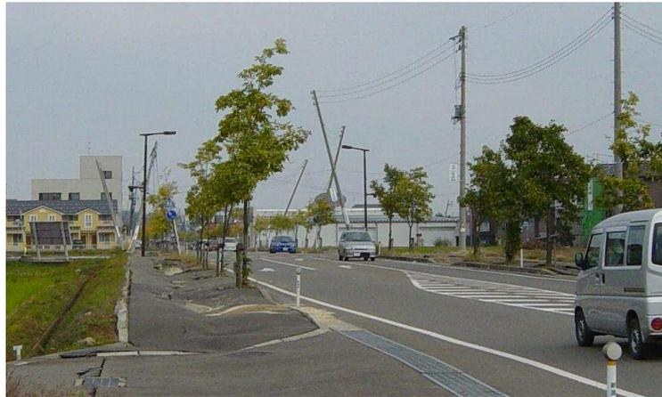
Figura 15 – effetti derivanti da liquefazione (evento sismico a Chuetsu in Giappone)
