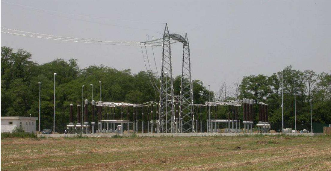
Figura 9 - Stazione di transizione aereo/cavo priva di reattanze per linea 380 kV in semplice terna aerea/doppia terna in cavo
