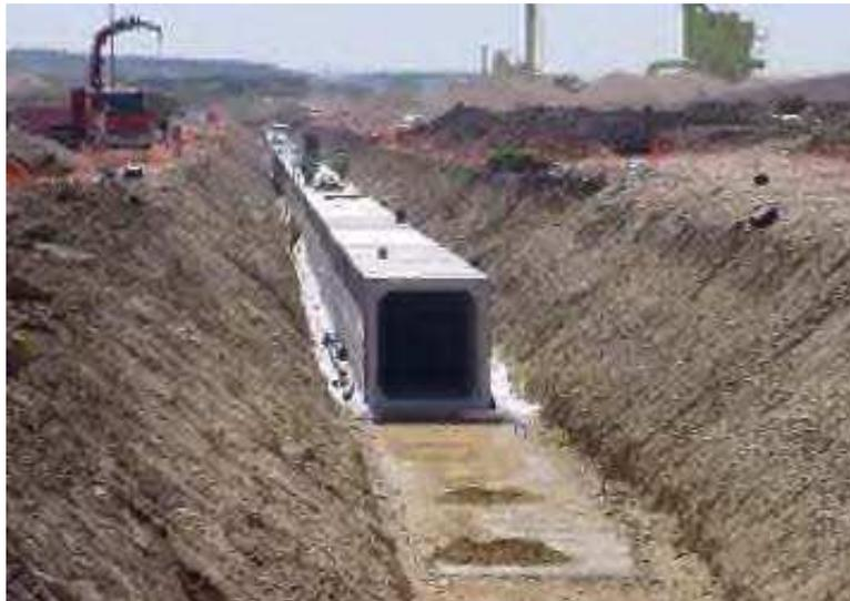
Figura 3 - Realizzazione di galleria in cui alloggiare cavo a 380 kV sotto aeroporto di Barajas a Madrid
