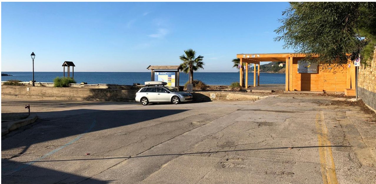
Figura 3 - Interferenza per accesso alla zona operativa 1 - Necessaria realizzazione rampa per scavalcare muro e permettere ai mezzi di raggiungere l'area operativa 1
