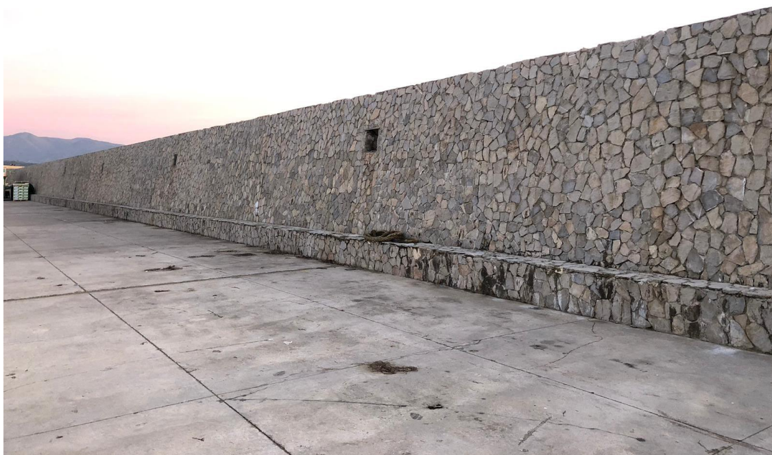
Figura 5 - Muro paraonde del molo sopraflutto da demolire per realizzare la sottozona operativa
