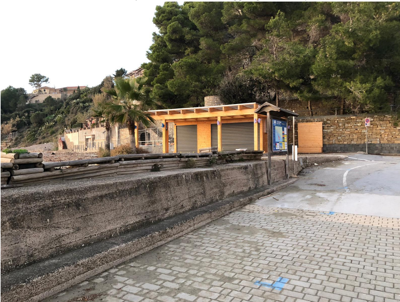
Figura 4 - Interferenza per accesso alla zona operativa 1 - Necessaria realizzazione rampa per scavalcare muro e permettere ai mezzi di raggiungere l'area operativa 1
