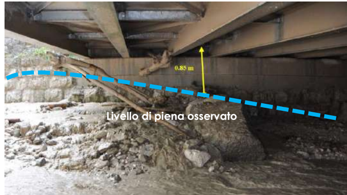
Figura 7.56 – Profilo idraulico ottenuto con il modello TRENT 2D e ponte SR48 presidiato da barriere provvisorie in seguito agli allagamenti dell'Agosto 2017
