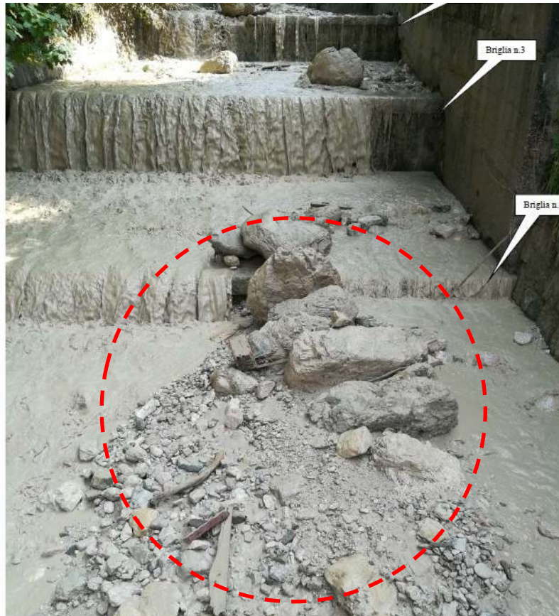
Figura 8.10 – Accumulo di materiale in corrispondenza dell'area oggetto di insufficienza della sezione (Foto Ing. Roland Bernardi 2018)
