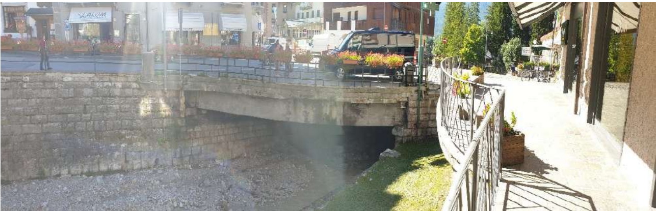
Figura 2.30– Ponte di Corso Italia vista da monte
