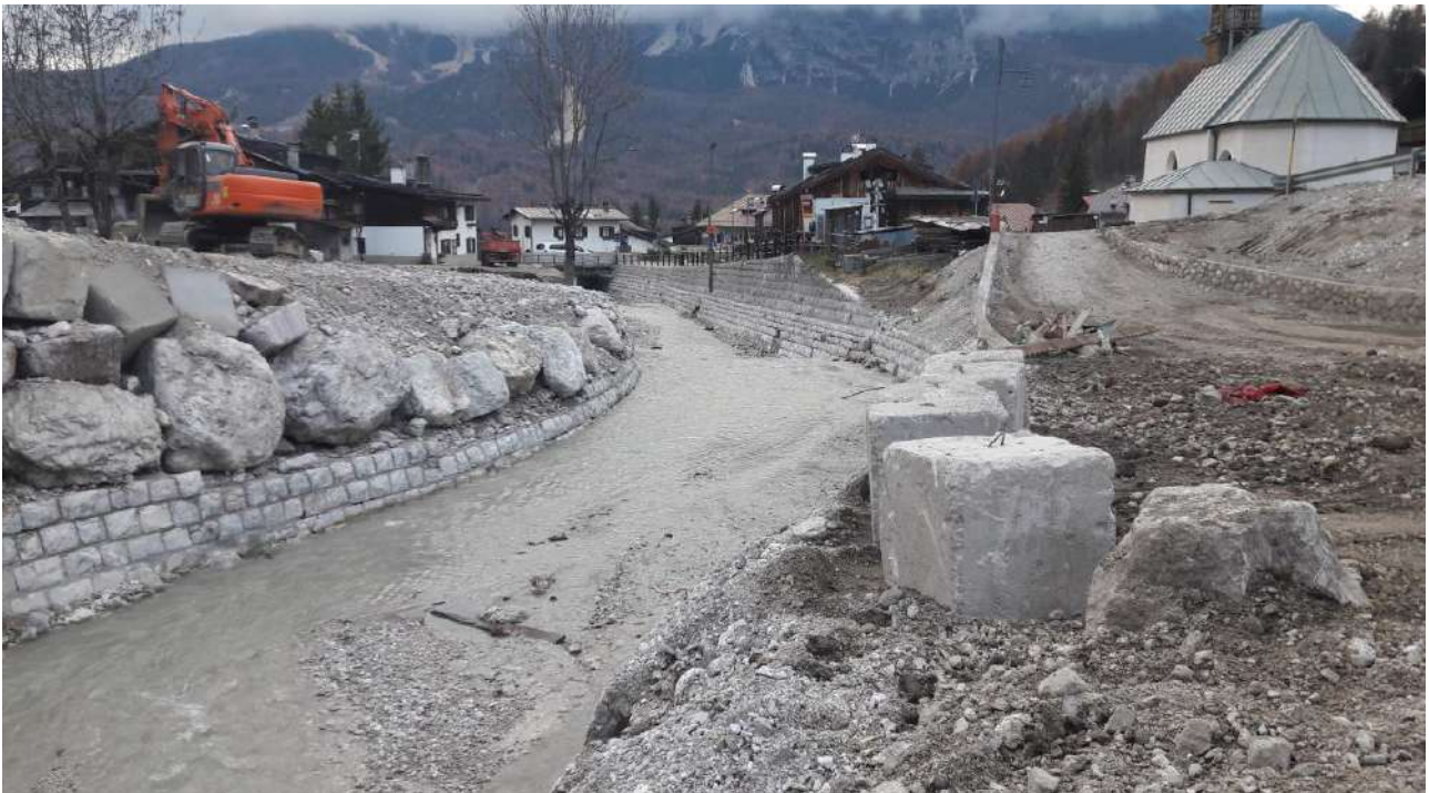
Figura 2.9– Tratto in sovralluvionamento parcheggio in curva (rilievo Dicembre 2018)
