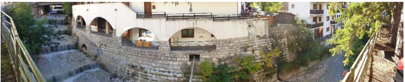
Figura 2.35– t. Bigontina Tra ponte di Corso Italia e Via Olimpia
