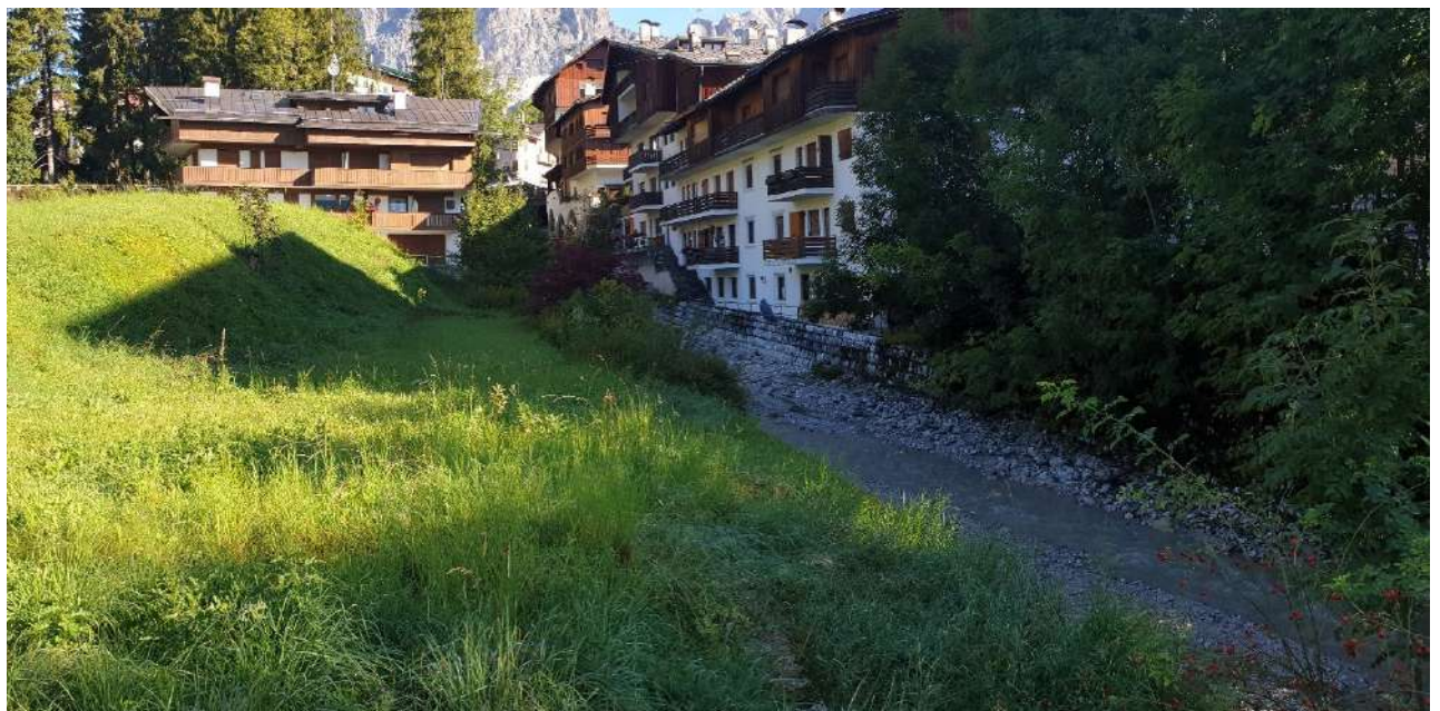
Figura 2.36– t. Bigontina a monte del ponte su Via Olimpia
