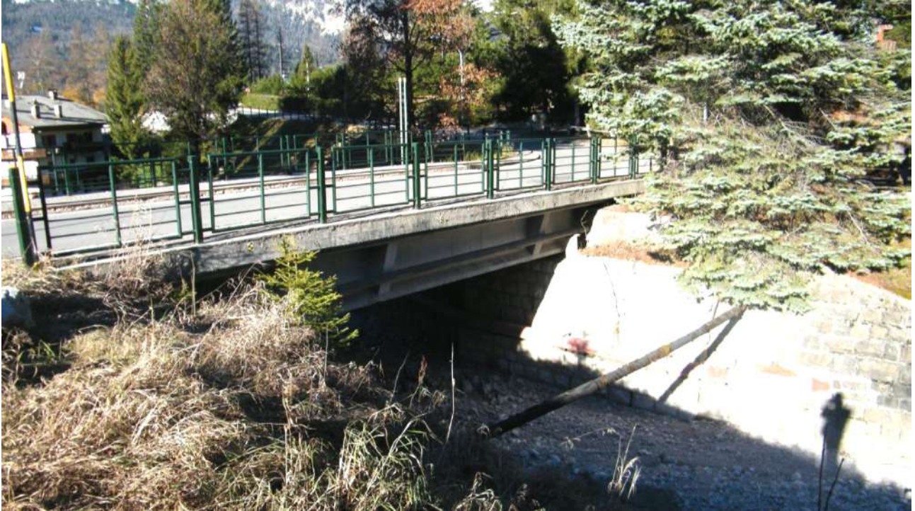
Figura 2.23– Inquadramento dell'area – ponte sulla strada per la frazione di Pecol ( rilievo Dicembre 2018)
