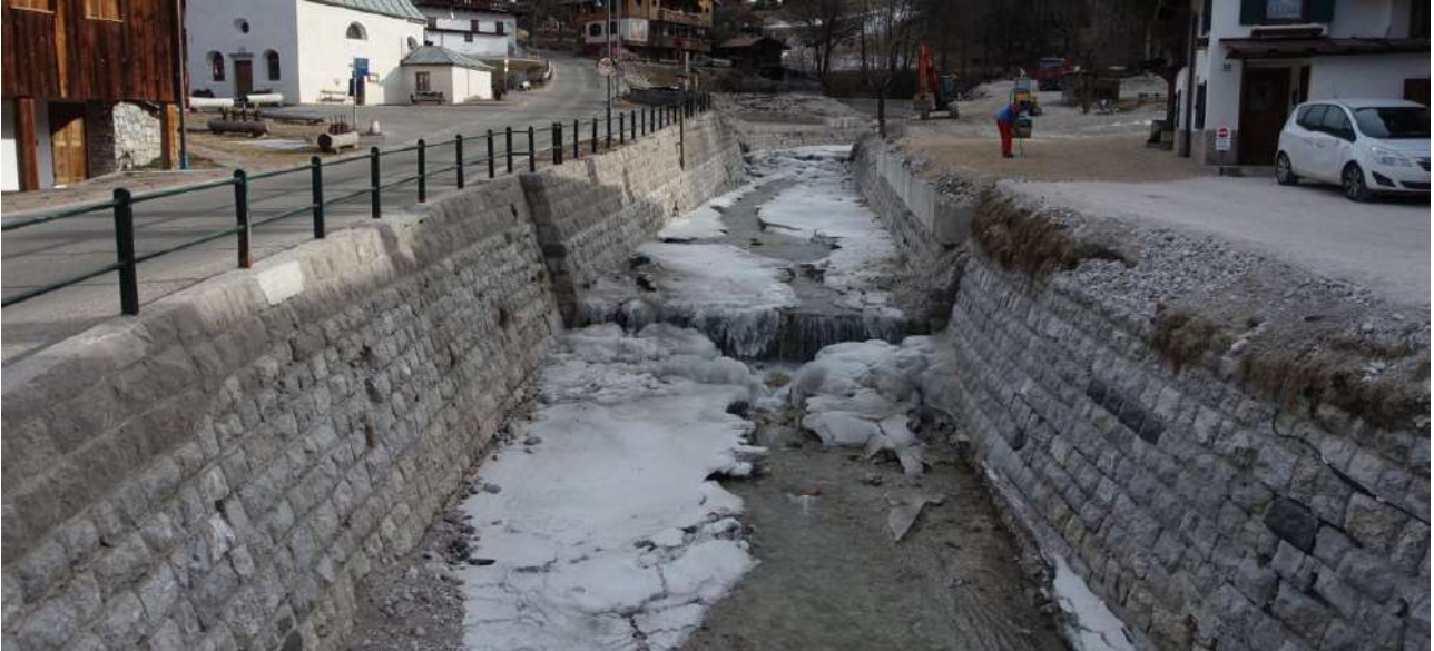
Figura 2.11– vista a monte del ponte sulla SR48 (rilievo Dicembre 2018)
