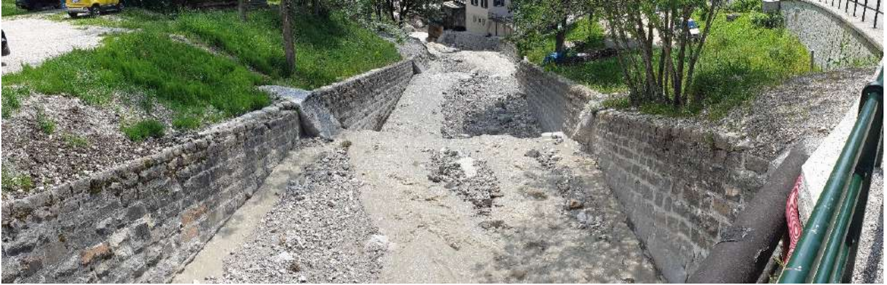
Figura 2.8– Tratto a valle del ponte in frazione Alverà (sopralluogo Aprile 2019)
