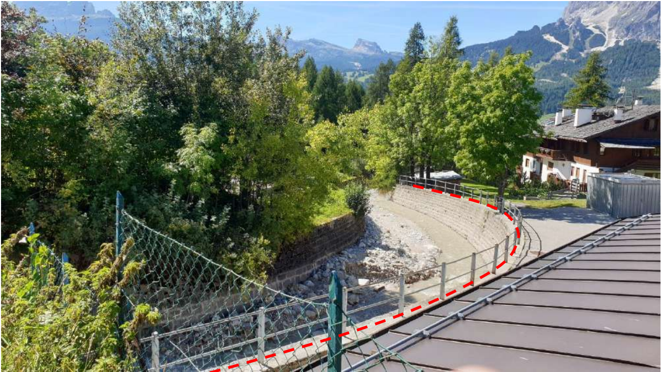
Figura 8.3 – Tratto di sponda destra oggetto di adeguamento del franco idraulico
