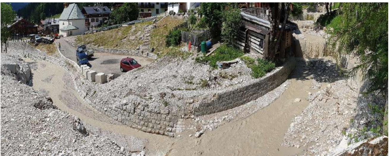
Figura 2.10– tratto in sovralluvionamento parcheggio in curva (sopralluogo Aprile 2019)
