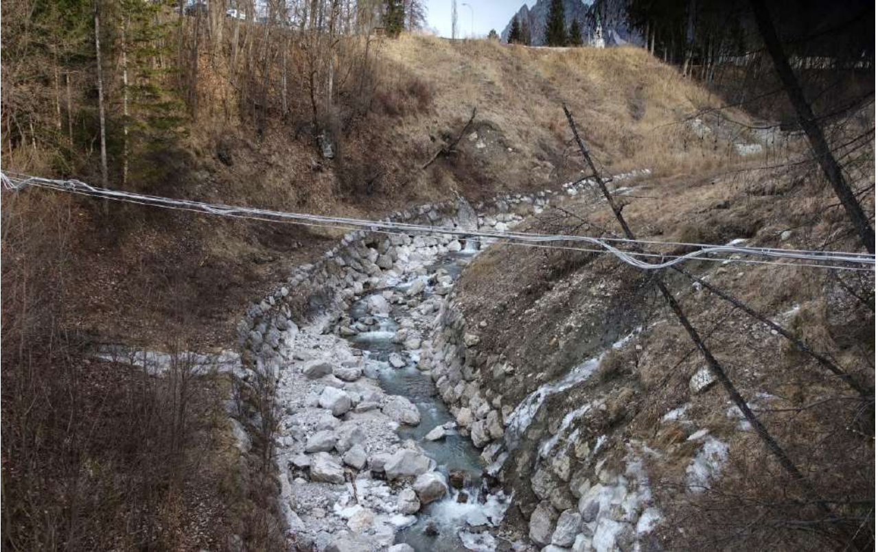
Figura 2.39– vista verso monte dal ponte tubo della fognatura ( rilievo Dicembre 2018)
