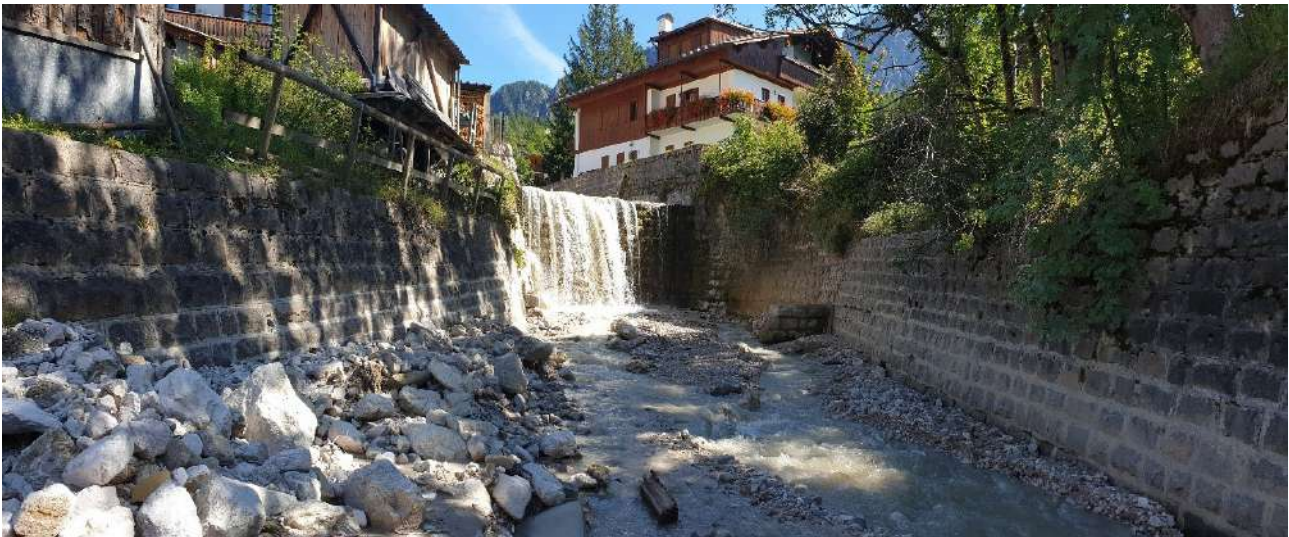
Figura 2.15– Briglia a valle della frazione di alverà ( sopralluogo Luglio 2019)
