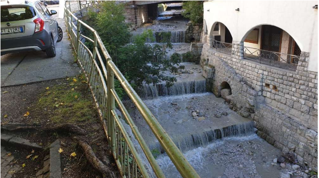
Figura 2.34– Briglie a valle del ponte su Corso Italia
