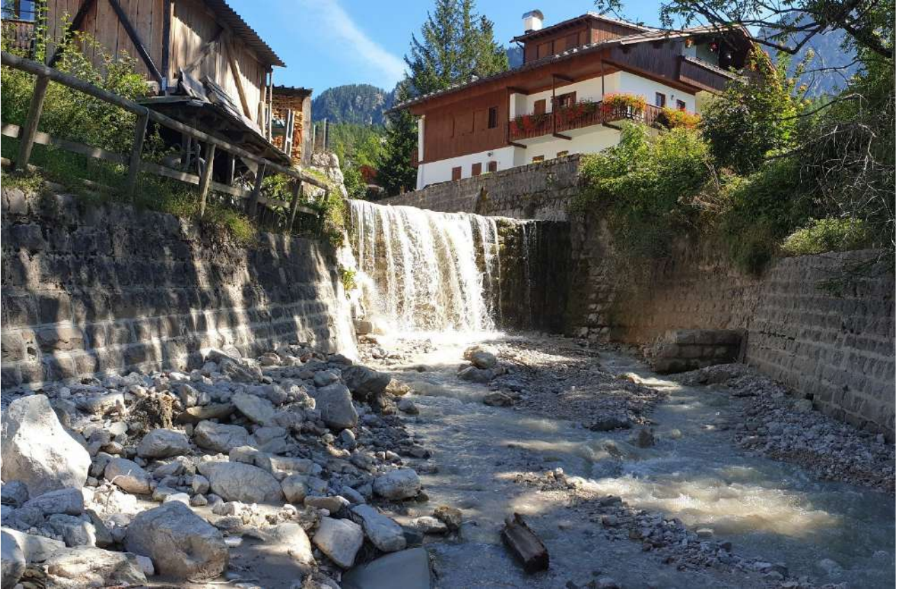
Figura 8.1 – Briglia da demolire tra le sezioni 34 e 35
