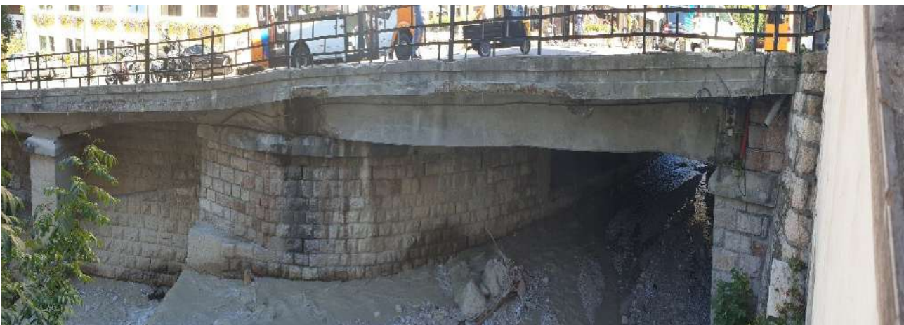
Figura 2.31– Ponte di Corso Italia vista da valle
