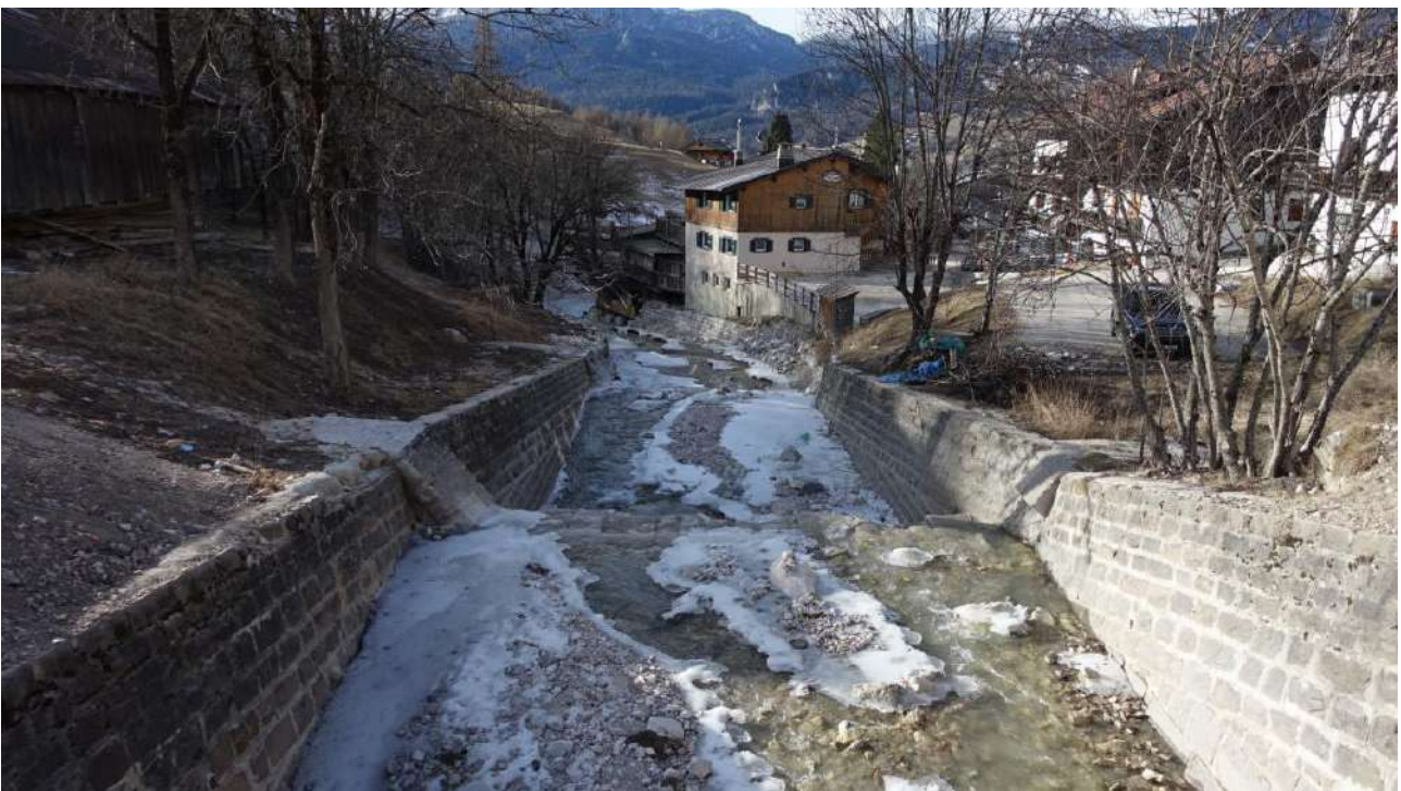
Figura 2.7– Tratto a valle del ponte in frazione Alverà (rilievo Dicembre 2018)
