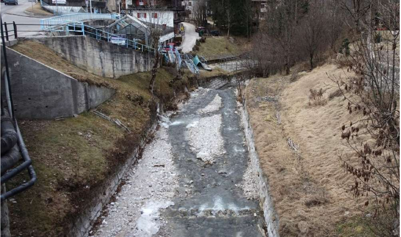
Figura 2.37– vista verso valle dal ponte sulla S.S. 51 ( rilievo Dicembre 2018)
