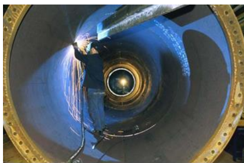
Figura 17: interno di una torre
