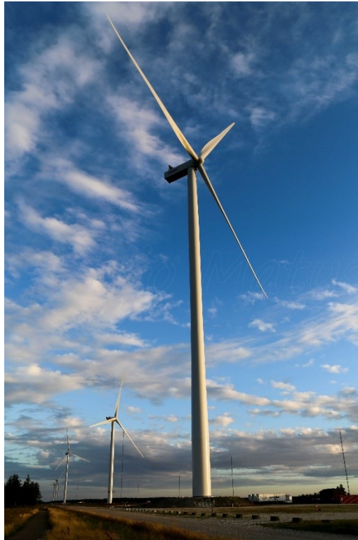
Figura 3 – Aerogeneratore Vestas V150
