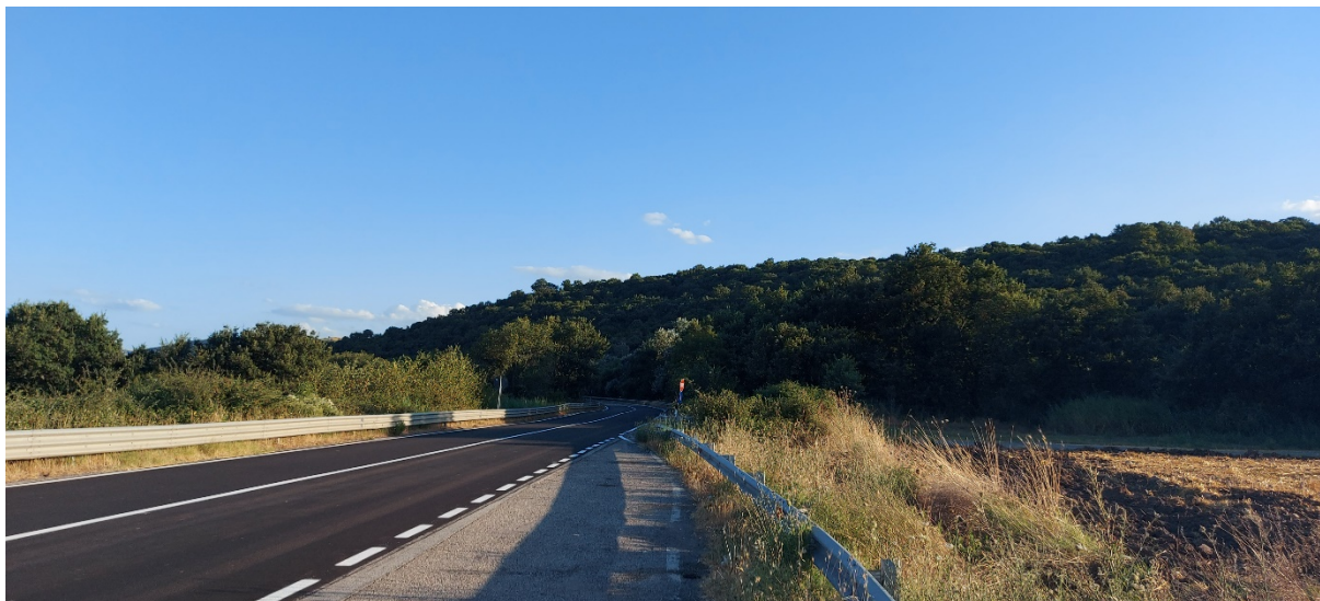
Stato di fatto – Punto di presa fotografica 1
