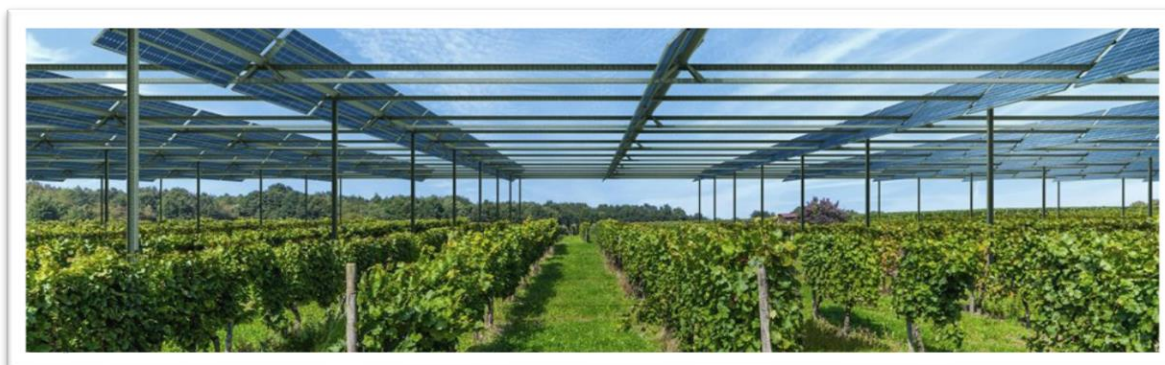
Figura 80. Esempio di Impianto “Agrivoltaico”.
