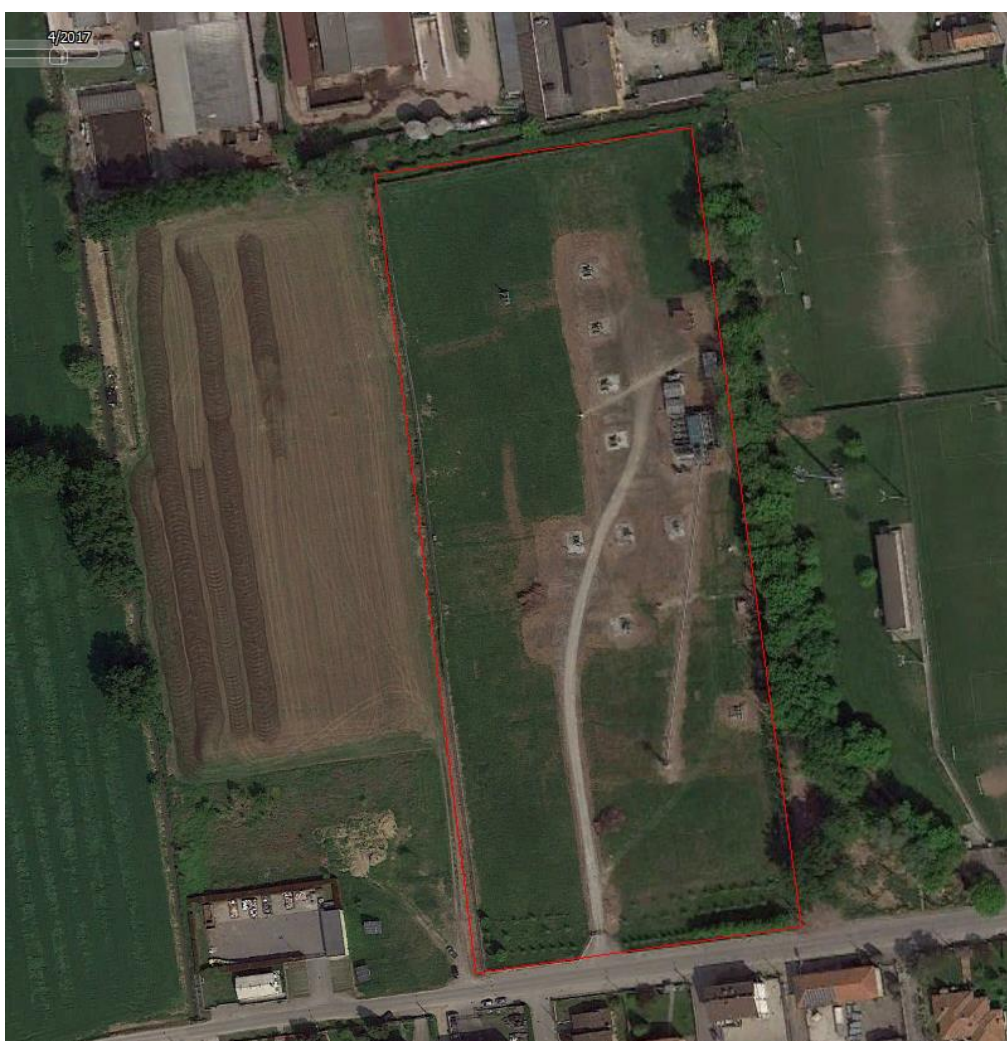
Figura 9 orto foto del 2017 dove risulta completamente assente la vegetazione arborea lungo il fosso di confine a ovest
