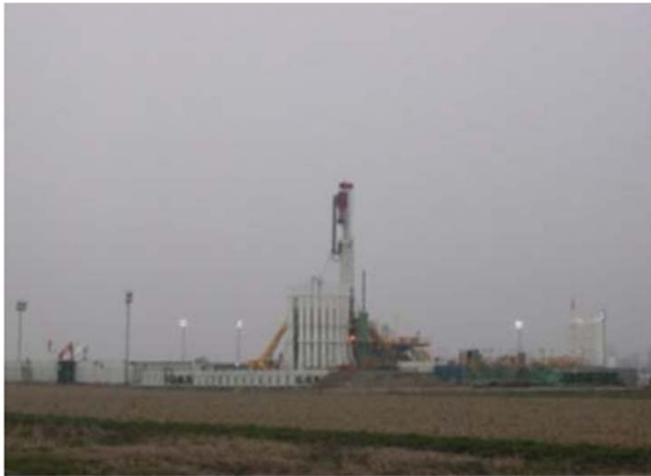
Figura 3-32 Vista Impianto di Perforazione HH220
