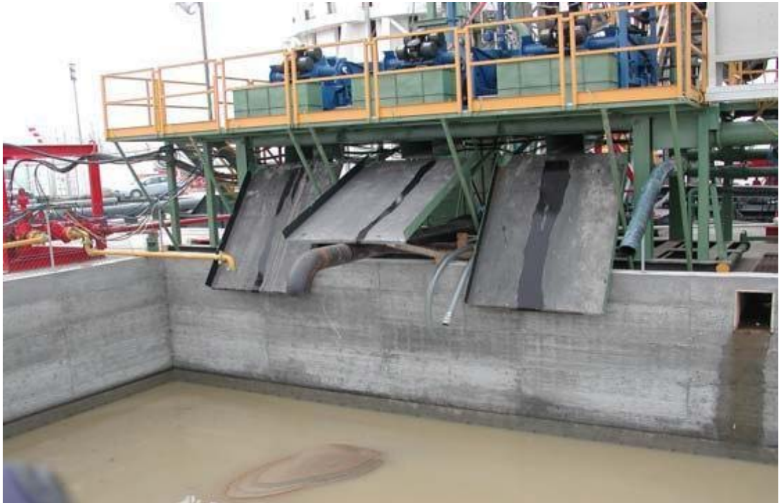
Figura 3-47 Scarto e Raccolta Detriti e Fango di Perforazione
