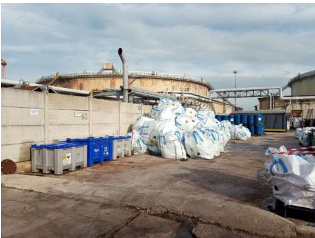
Foto 1: Esempio di area non idoneamente delimitata (nastro rosso) con big bags e fusti con etichetta non leggibile (area di deposito temporaneo 1).
