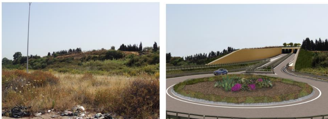
Figura 26 – Vista della trincea di approccio alla galleria artificiale Ante operam e Post operam
