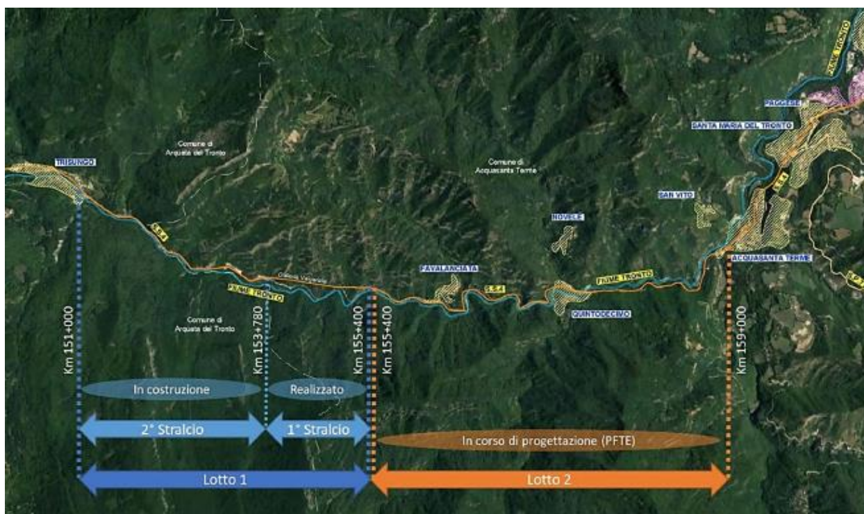
Figura 1 – Corografia e suddivisione in Lotti del tratto Trisungo – Acquasanta Terme (Inquadramento programmatico)
