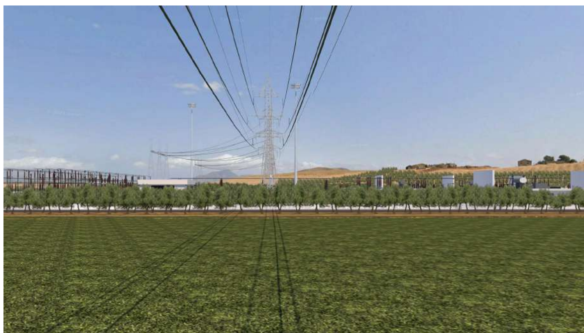
Fig. 39 B Vista esterna post operam dell'area della stazione rete-utente con mitigazione fotografata dalla SP 37
