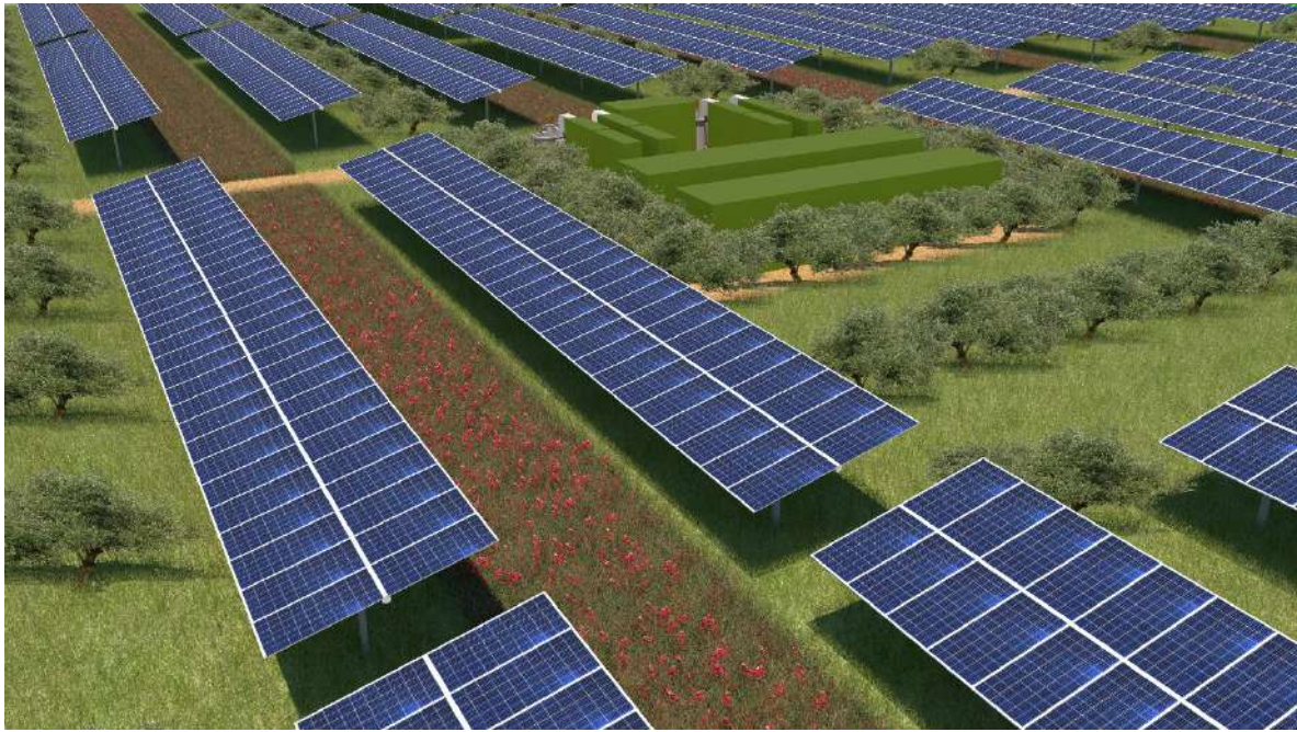
Fig. 27 - Mitigazione e Colorazione Cabine interne all’Impianto Agro-Fotovoltaico
