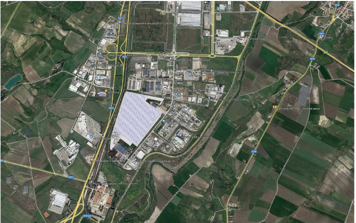
Figura 1 – area interessata dalla installazione
