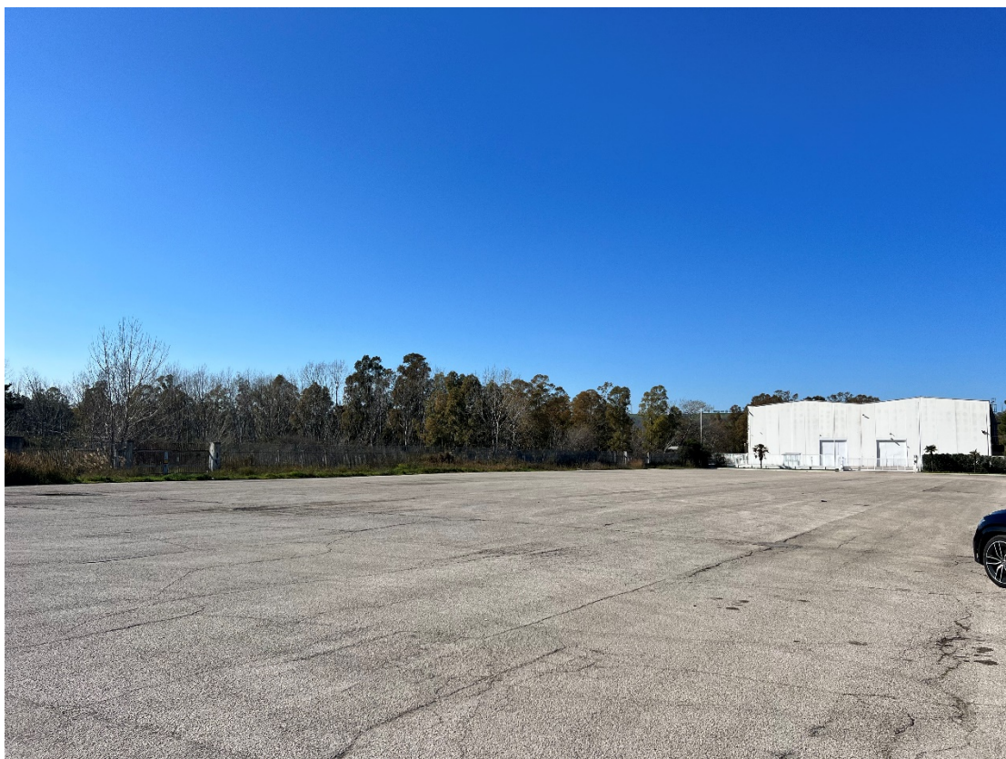
Foto 1 – Punto dinamico Strada consortile - Stato di fatto
