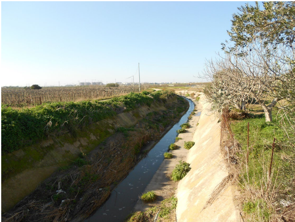
Foto 15: il Canale Ciappetta-Camaggio in località Fondischiavi in agro di Barletta
