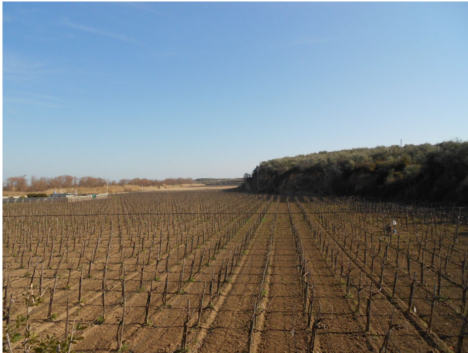
Foto 11: ripa di erosione nei "Depositi alluvionali terrazzati" del Fiume Ofanto (località Madonna del Petto).
