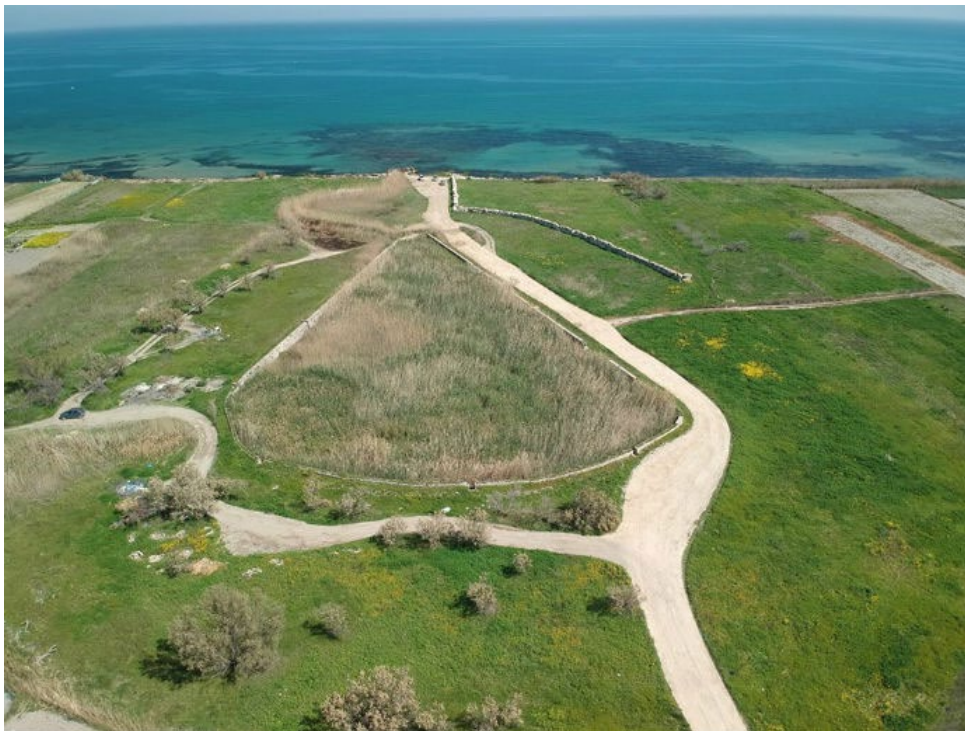
Vasca di Boccadoro parte di un vecchio acquedotto - Litorale Nord di Trani
