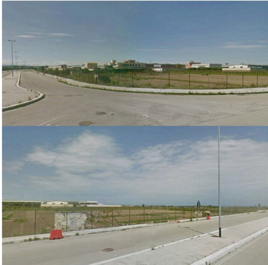
Rilievo fotografico dell'area di progetto della Stazione elettrica
