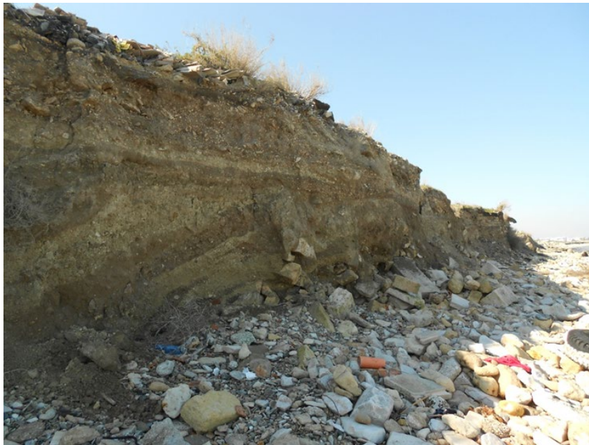
Ripa di erosione costiera intagliata in materiali di risulta - località Belvedere
