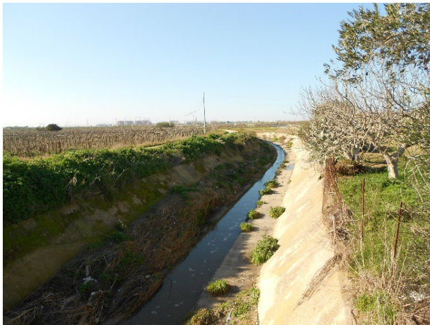
Canale Ciappetta-Camaggio in località Fondischiavi
