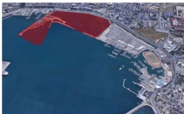
Bari – completamento colmata Marisabella
