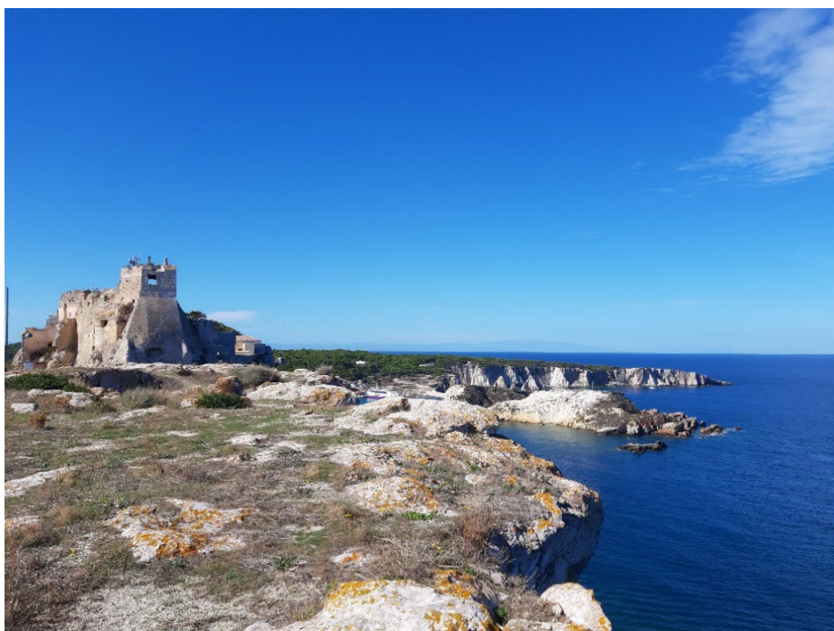
Figura 24: Visuale dalla postazione di osservazione verso O-NO. Sullo sfondo l'isola di San Domino e ancor più dietro la costa abruzzese
