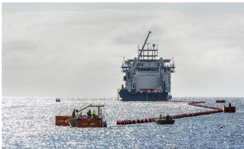
Figura 5.11: posa del cavo in corrispondenza del punto di approdo
