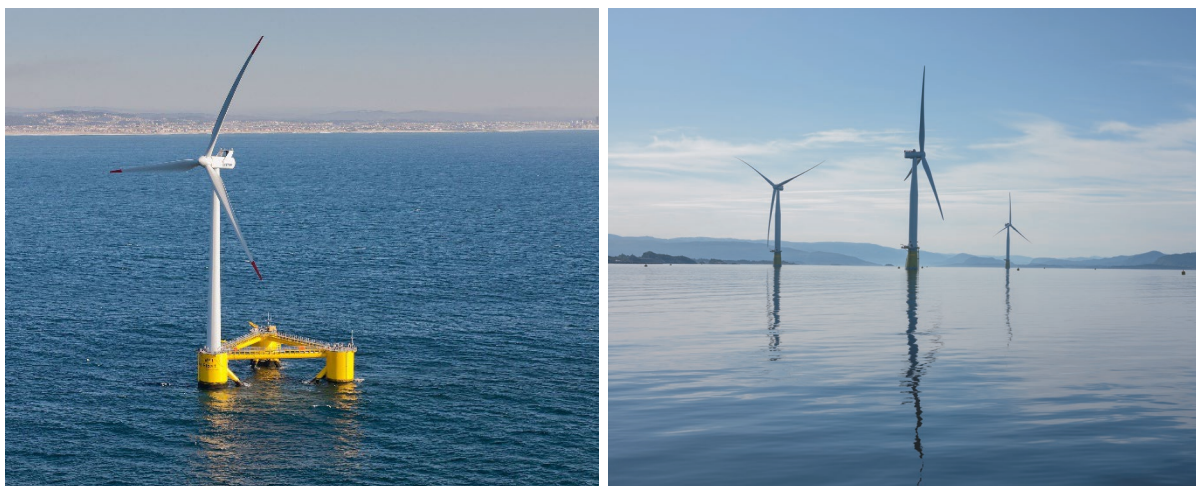
Figura 5.1: (a sinistra) semisommersibile di Principle Power 1 , (a destra) Hywind spar 2
