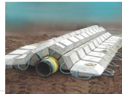
Posa in appoggio | gusci di ghisa – materassi - rocce
