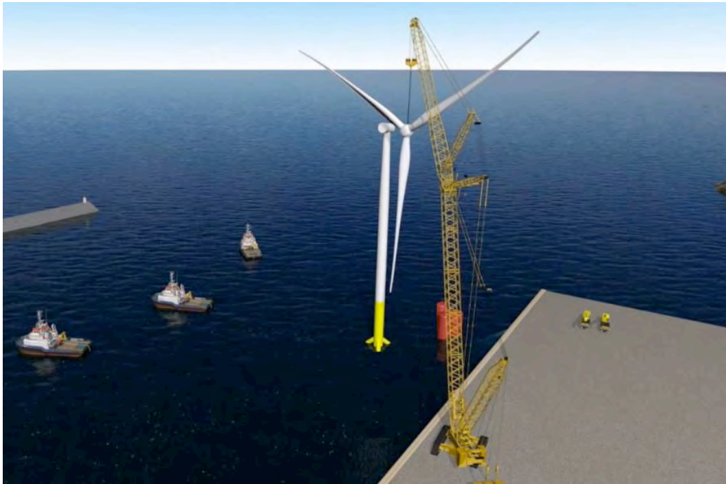
Montaggio di un aerogeneratore in banchina
