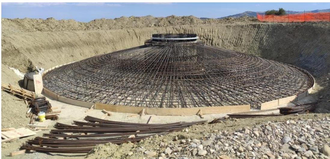
**Figura 5-4: immagine tipo armature plinto**
