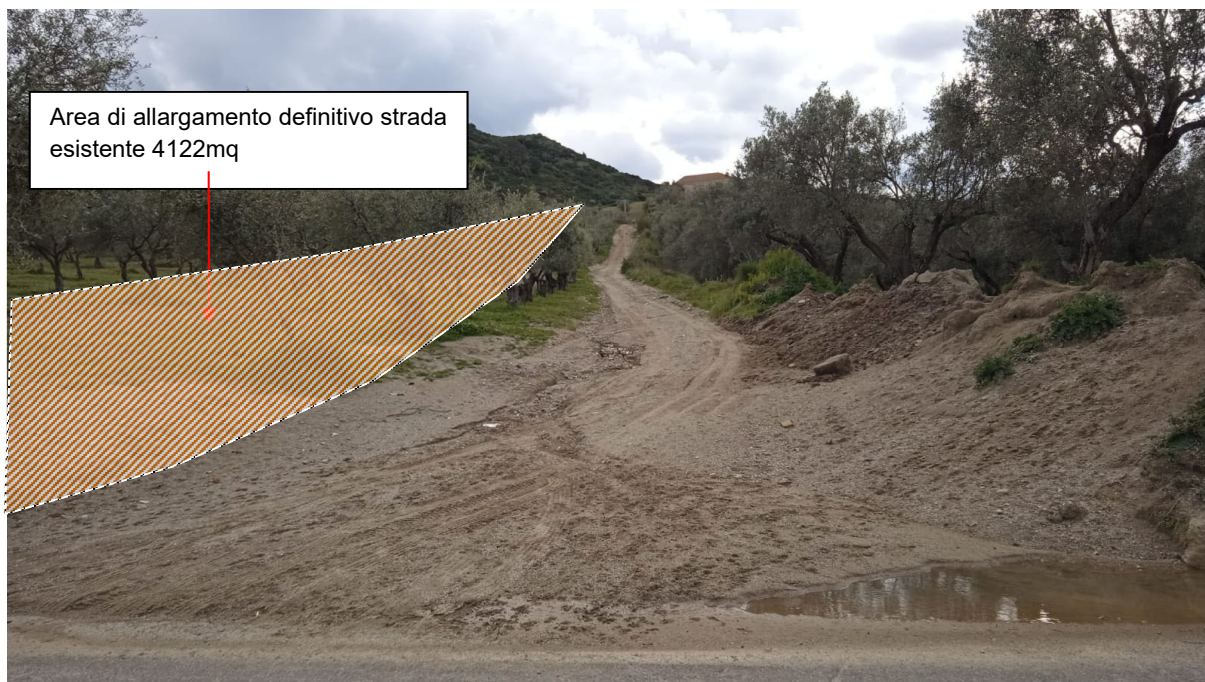
Fig.63-Foto n.2 di figura n.61 bivio SP47 da adeguare
