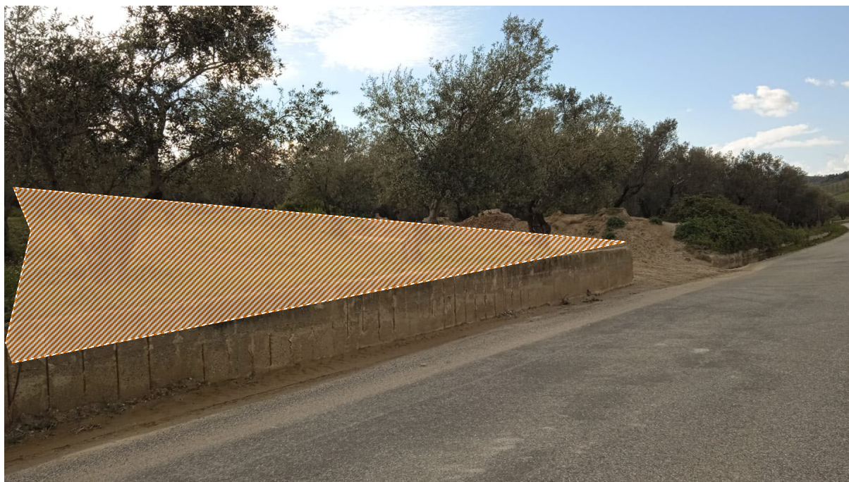
Fig.64-Foto n.3 di figura n.61 bivio SP47 da adeguare
