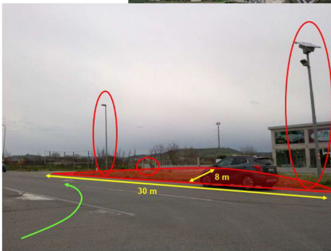
Fig.27-Rimozione ostacoli ed allargamenti sede viaria
