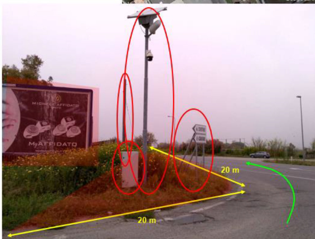
Fig.26-Rimozione ostacoli ed allargamenti sede viaria
