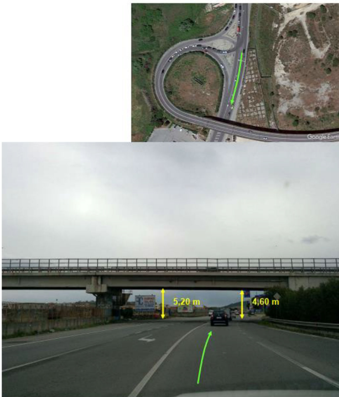
Fig.28- Ostacolo luce libera ponte su SS106
