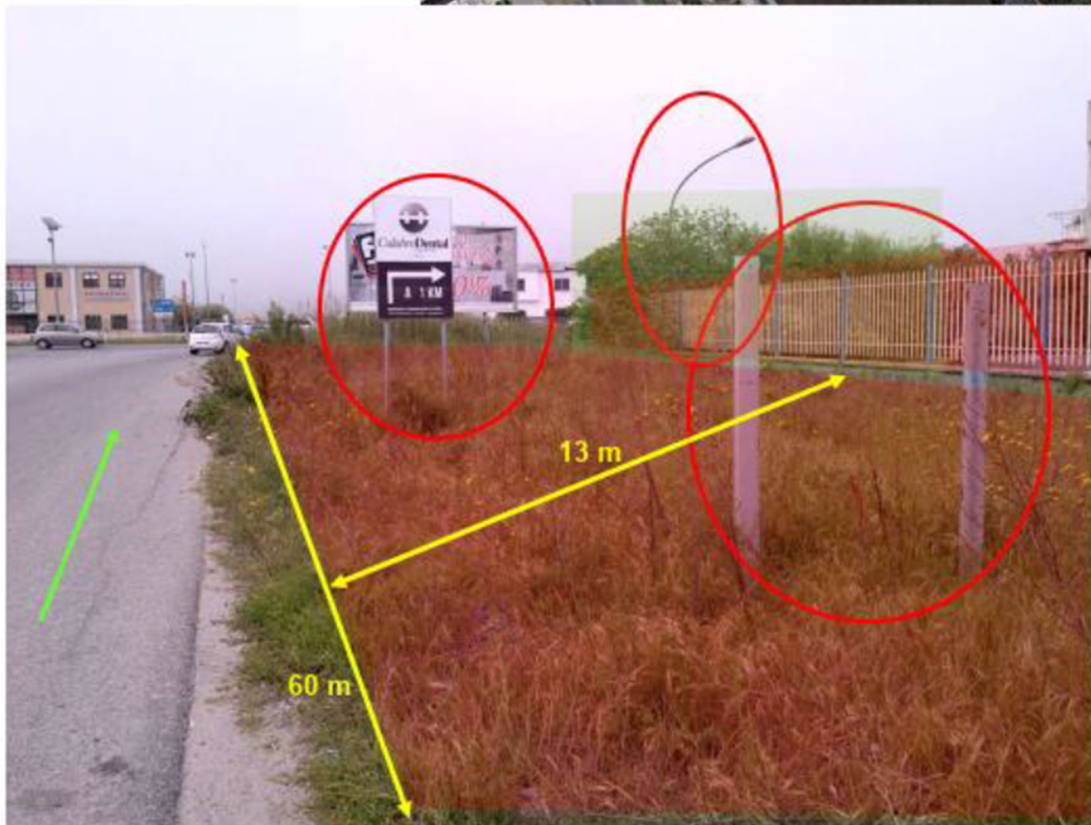
Fig.25-Rimozione ostacoli ed allargamenti sede viaria
