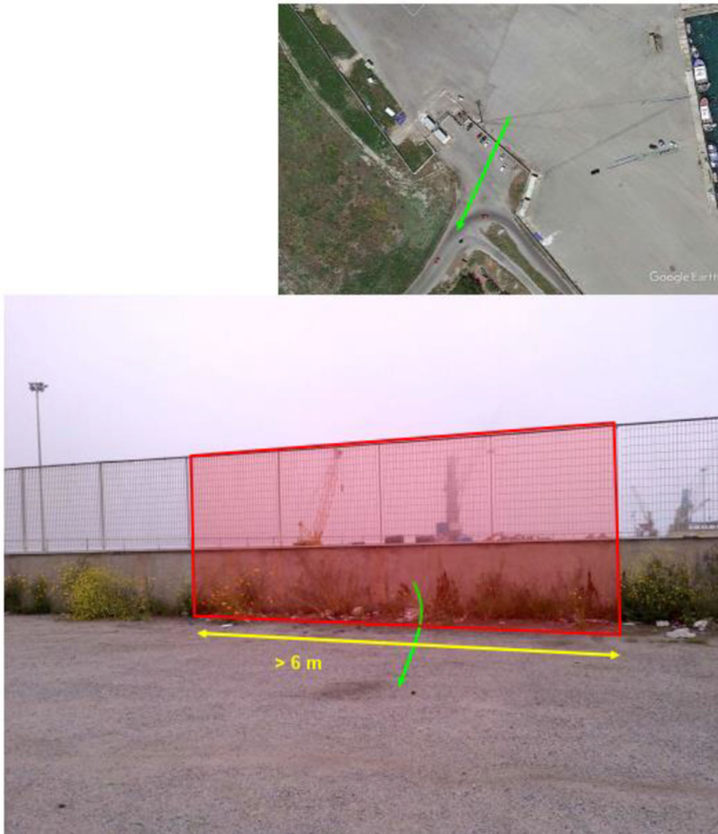
Fig.18-Demolizione Recinzione porto di Crotona
