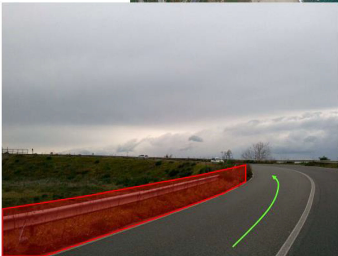
Fig.23-Rimozione guard rail
