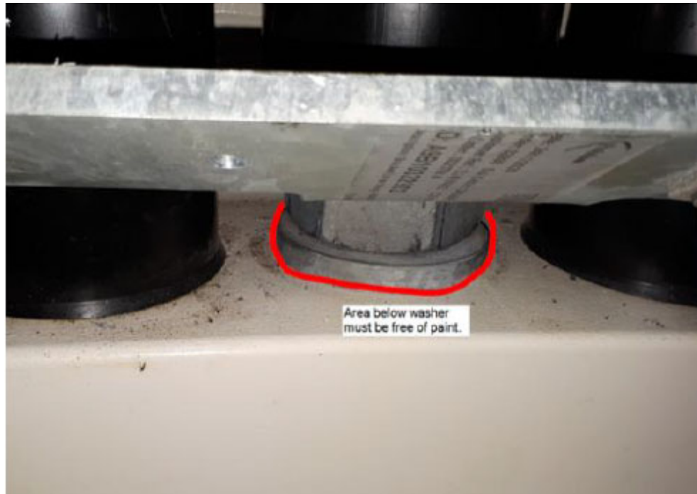
Fig.5 Illustrazione della vernice da rimuovere sulla flangia della torre sotto la rondella.
