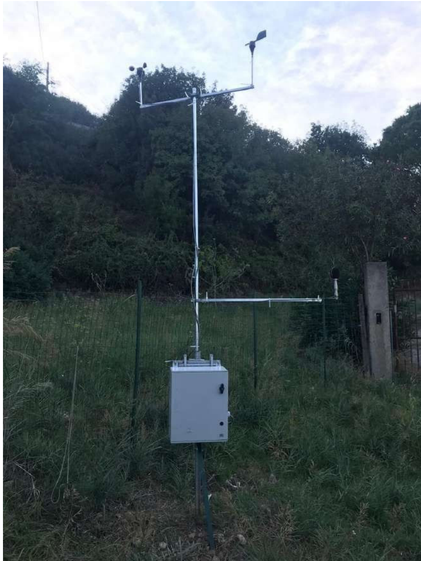
Figura 11 – Misura M1 – vista e posizione strumento di misura
