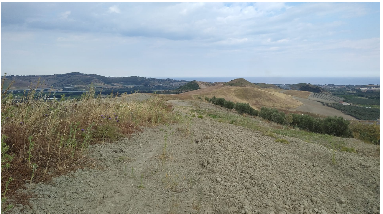
FIG. 5 – AREA AEROGENERATORE E5 E PUNTO DI INSTALLAZIONE – SITUAZIONE REALE (FOTO DA OVEST)
