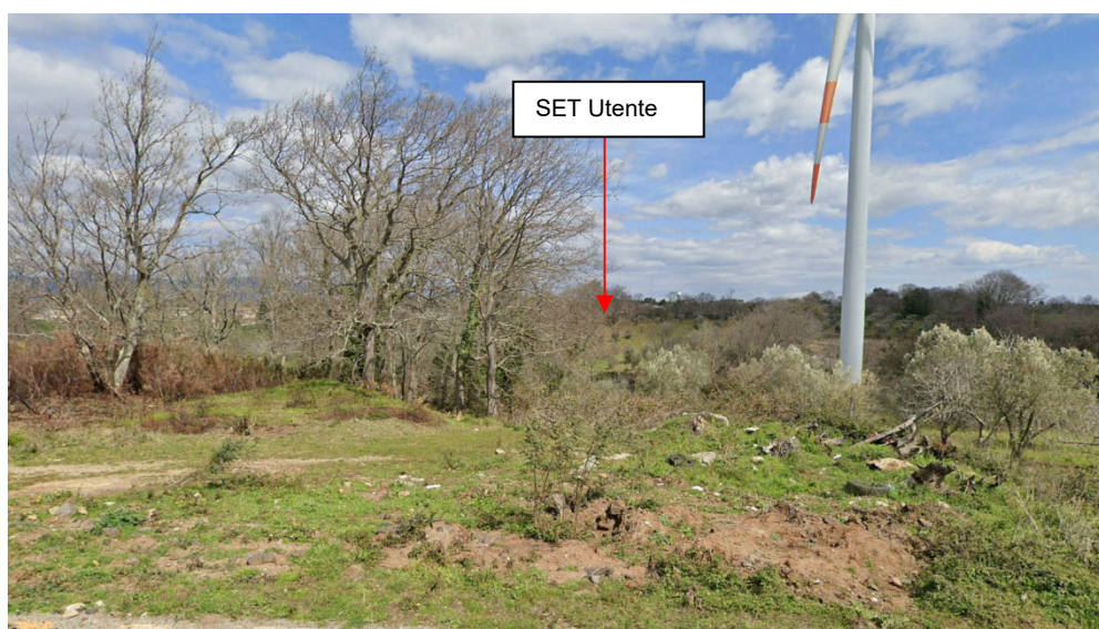
FIG. 30- FOTO SITO DI INSTALLAZIONE STAZIONE ELETTRICA DI TRASFORMAZIONE
