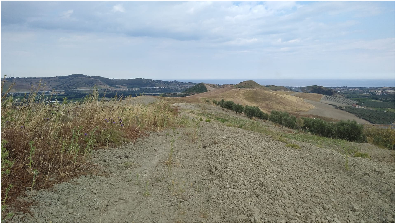
FIG.24– AREA AEROGENERATORI E5 – SITUAZIONE REALE (FOTO DA OVEST)
