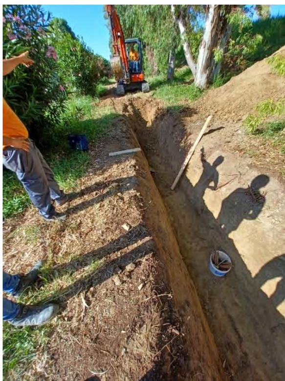
**Figura 1** Esempio di uno scavo in linea
