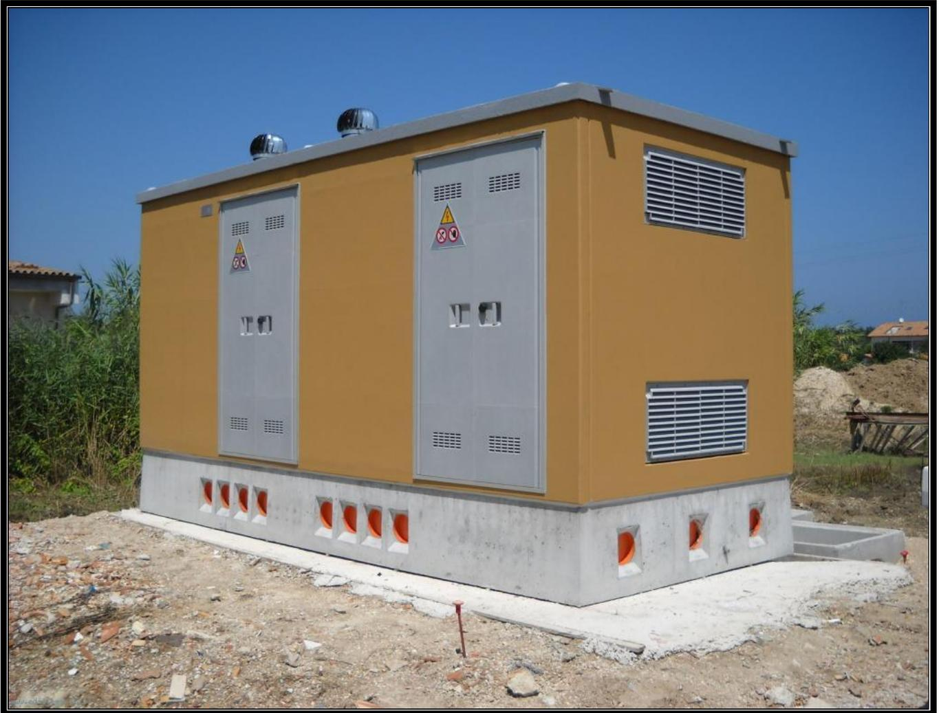
**Figura 9 - Esempio di cabina di parallelo AT**
