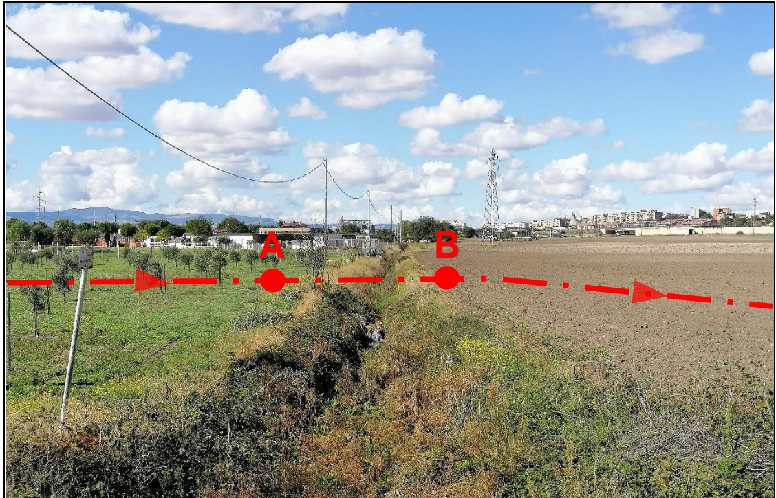
Figura 3.b: Panoramica della zona dell'attraversamento del Canale affluente Torrente Vulgano.
