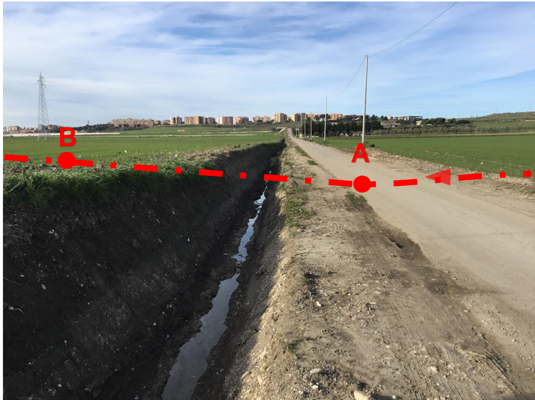
Figura 3.b: Panoramica della zona dell'attraversamento del Fosso considerato.
