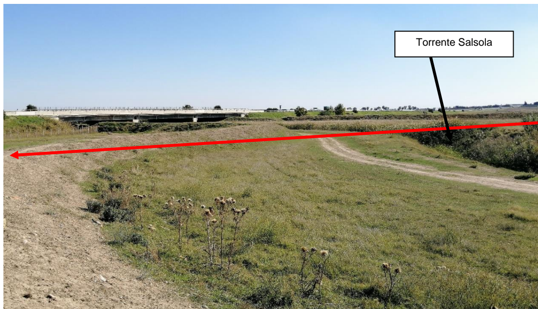
Figura 3.a: Attraversamento Torrente Salsola e relativa area golenale (panoramica contro senso-gas). gasdotto in progetto in rosso
