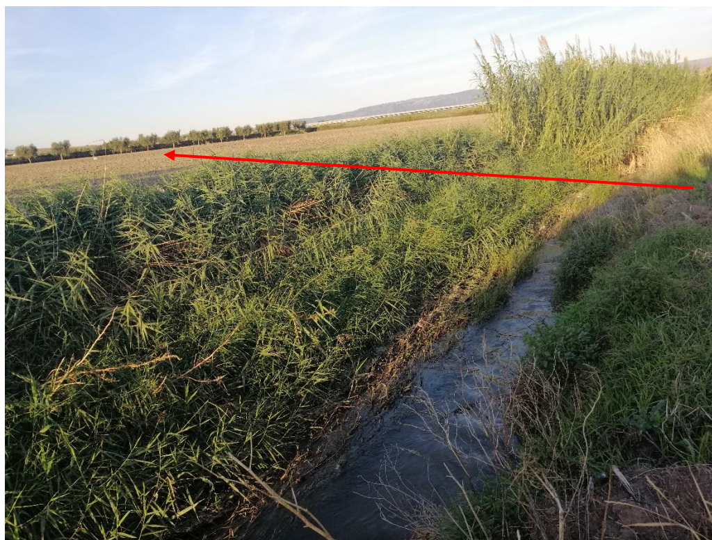
Fig. 5-3 – Canale Venolo nei pressi dell'interferenza con il metanodotto in progetto Tratto 3 (in rosso il tracciato del metanodotto).
