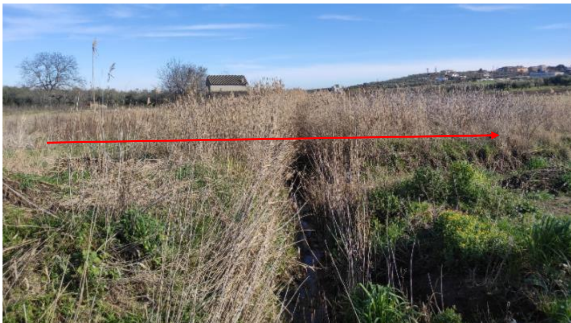
Fig. 5-7 –Attraversamento del Vallone del Rovello da parte del metanodotto in progetto Tratto 4 (in rosso il metanodotto).
