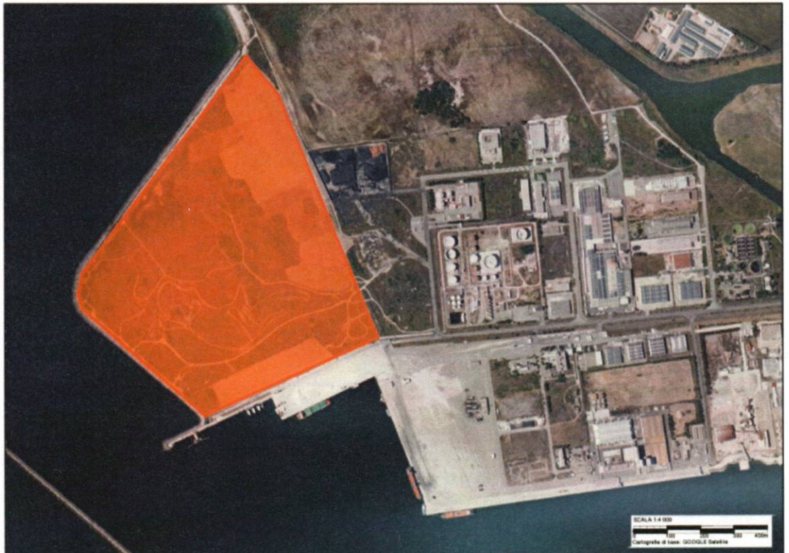
(da SPA, Inquadramento aree logistiche e di cantiere su ctr, ortofoto, carta nautica e catastale , particolare con rappresentazione dell'area di cantiere nel Porto Industriale di Oristano, nel comune di Santa Giusta)
