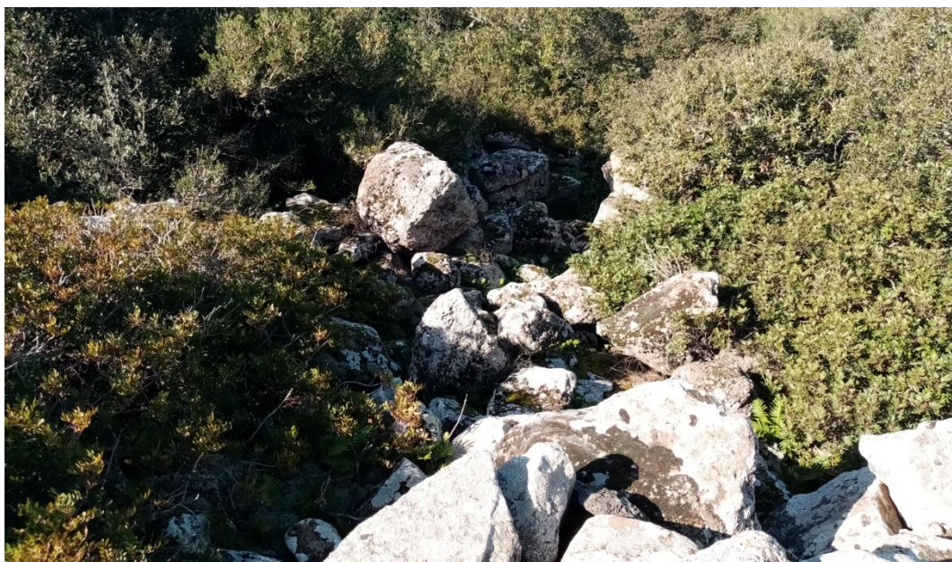
Fig. 12. Ingresso del bastione visto dal crollo del mastio (foto dell'autore).
