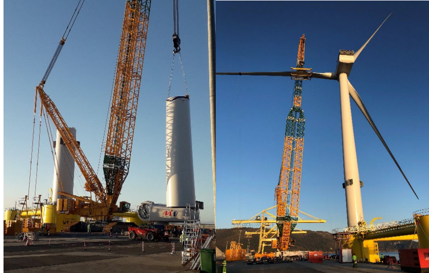
Figura 6.3 – Installazione della torre e della turbina
