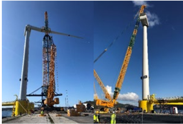
Figura 4.9 – Installazione della turbina eolica
