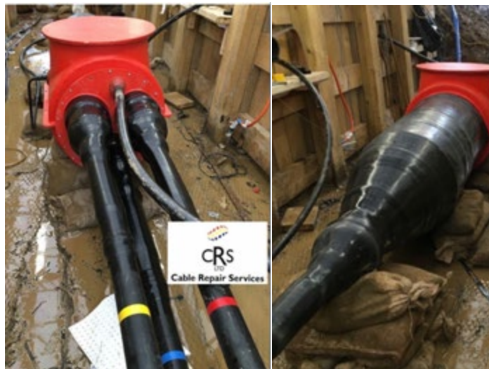
Figura 4.15 – Giuntura di transizione sulla terraferma.
