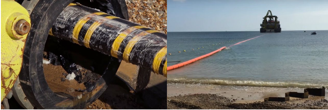
Figura 4.18 – Inserimento di un cavo export offshore sulla riva.
