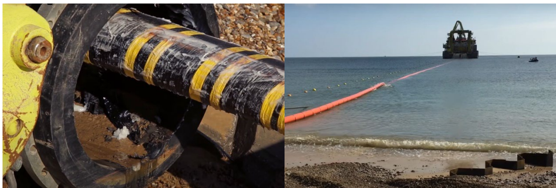
Figura 2.9 Inserimento di un cavo export offshore sulla riva.
