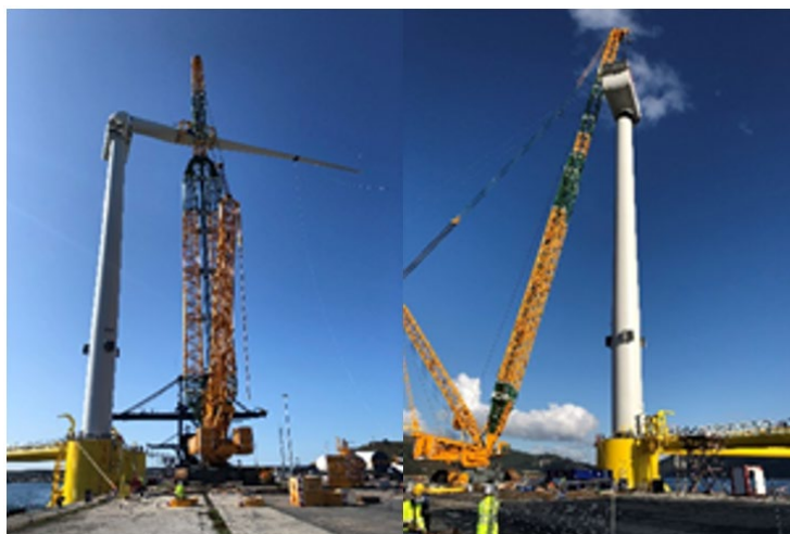
Figura 2.7 Installazione della turbina eolica
