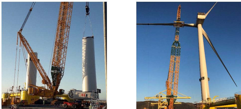
Figura 2.22 Installazione della torre e della turbina
