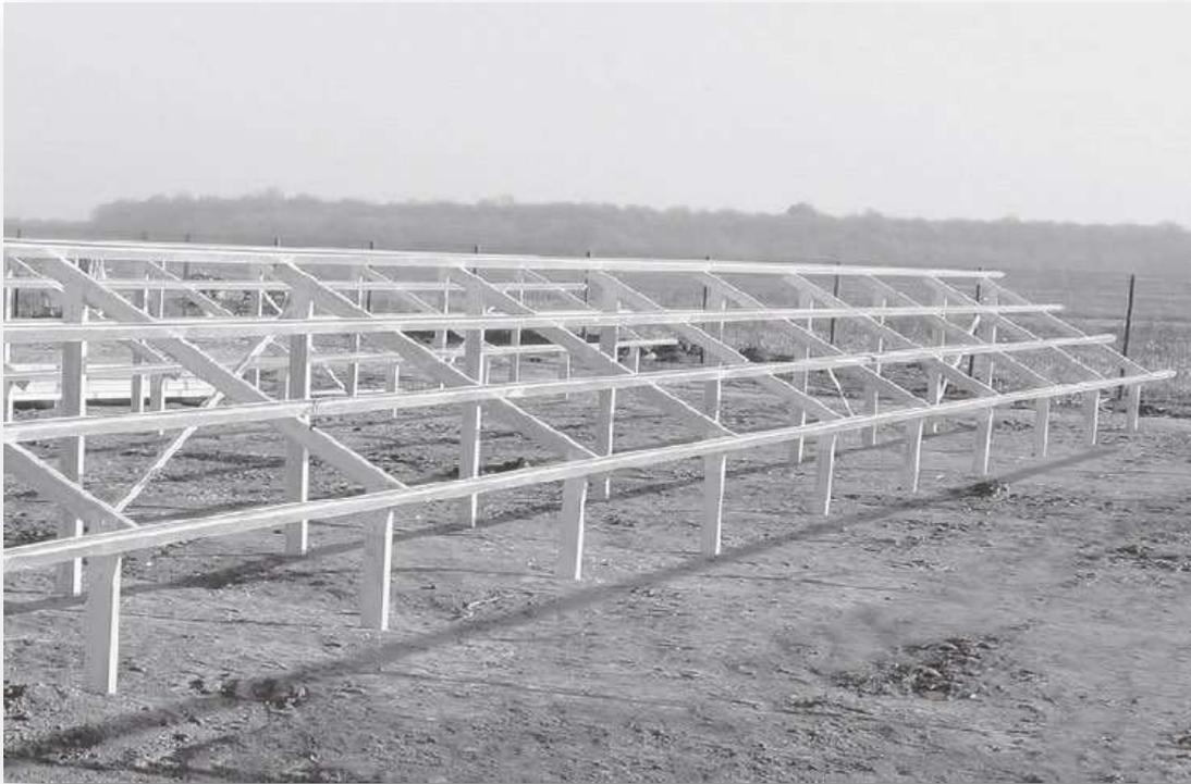
Figura 24- Struttura fissa
