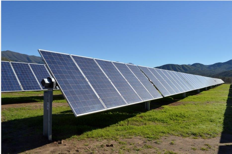
Figura 23 - Vista prospettica inseguitore solare monoassiale
